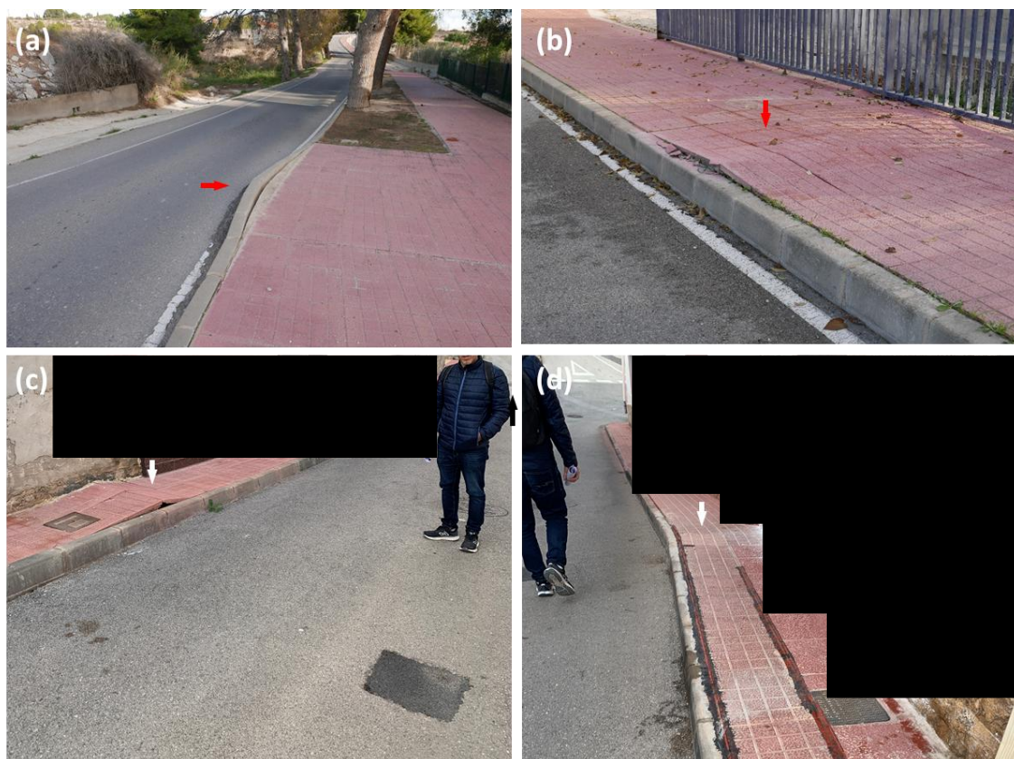
Figura 16. Estructuras de flexión por compresión identificadas en el Camino del Cementerio, en las inmediaciones de la comisaría de la Policía Local de Monóvar y en el extremo oeste de la calle Raval Cuartel.
