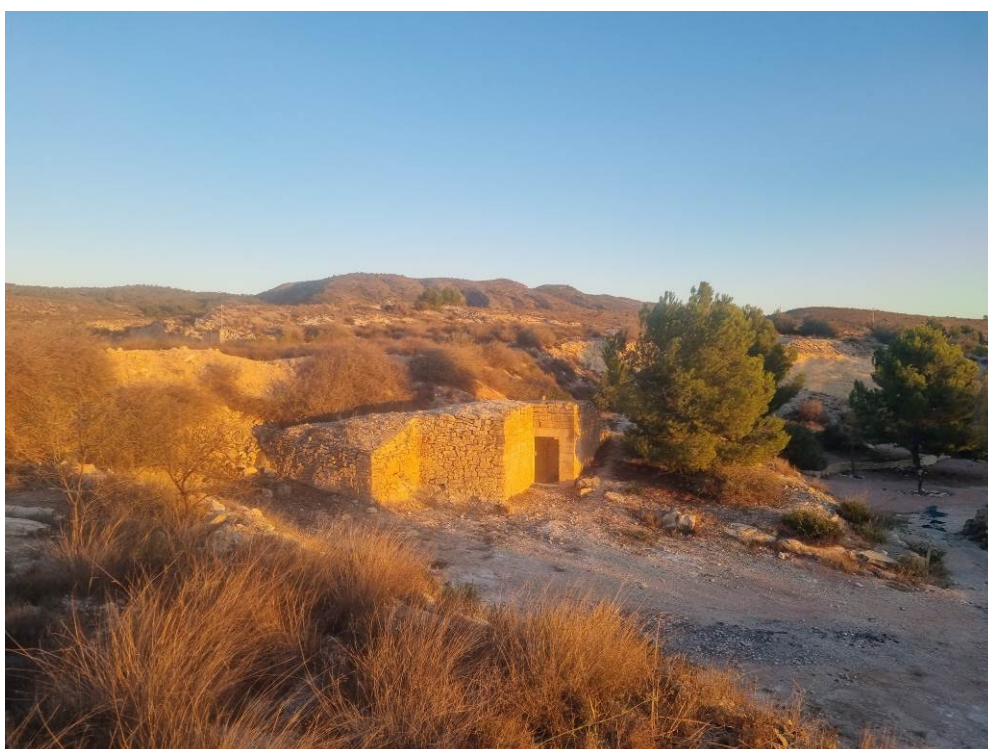
Fig. 108: Aspecto exterior del refugio una vez finalizados sus trabajos de rehabilitación patrimonial. A la derecha área recreativa, en la que se halla la cantera de este refugio.
