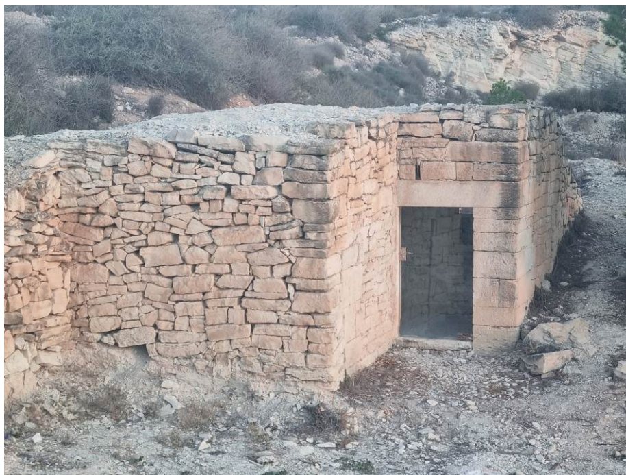
Fig. 89: Vista desde el sur del refugio con su acceso actual.
