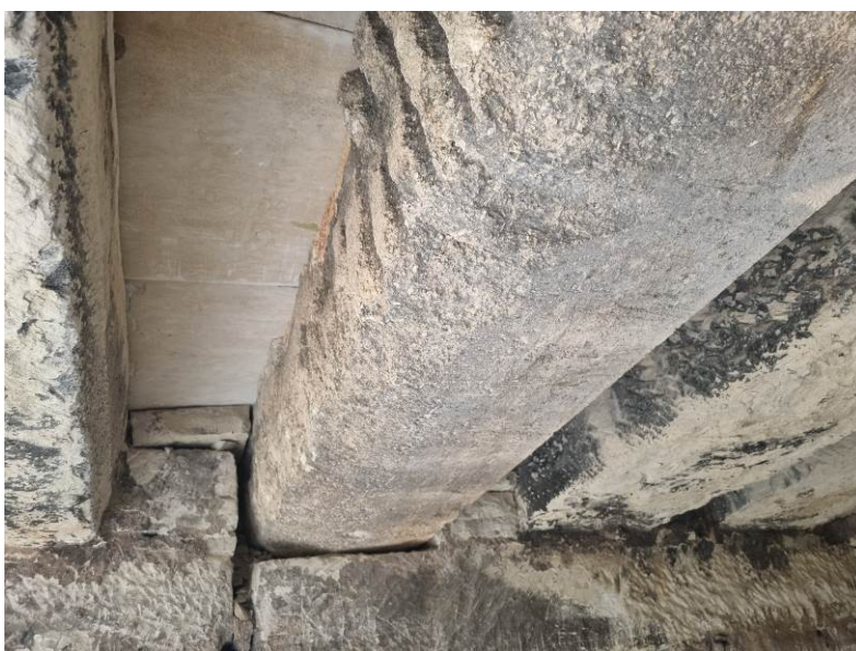
Fig. 99: Detalle de las nuevas losas y nueva viga colocada en la cámara 2 del refugio.
