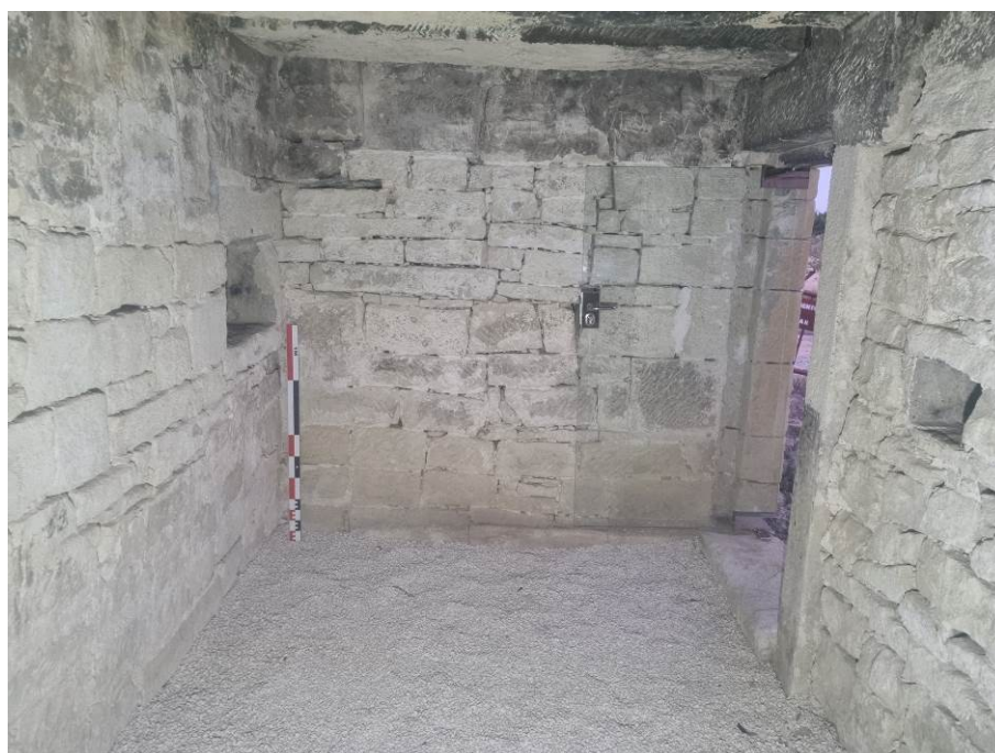
Fig. 80: Interior del refugio, su sala 2, una vez recuperado su pavimento con grava.
