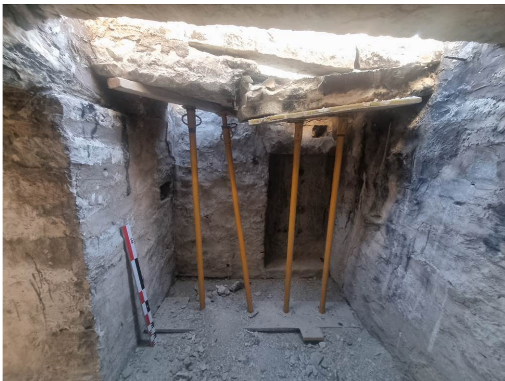
Fig. 29: Cámara 1 una vez extraídas las tierras de la techumbre, en las que se observa la situación de las vigas fisuradas a extraer. 13 octubre 2023.
