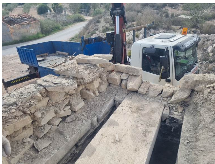
Fig. 69: Proceso de reconstrucción de la fachada sur, zona superior, a recuperar a la vez que se realizaba el sellado de la cubierta del refugio.
