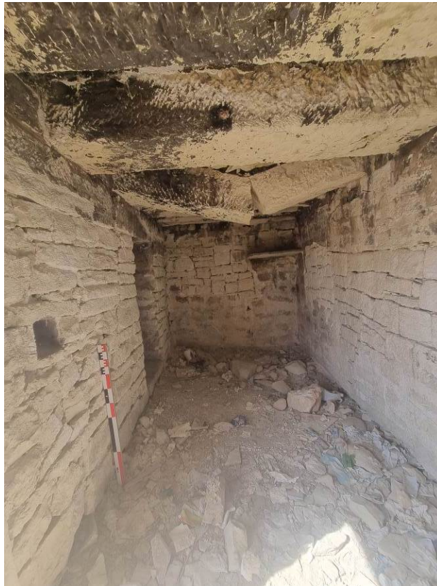
Fig. 16: Interior del refugio de cantero nº 6 de la Canyadeta en Monòver. Se observa la viga a punto de colapsar de la cámara nº 2. Marzo 2023.
