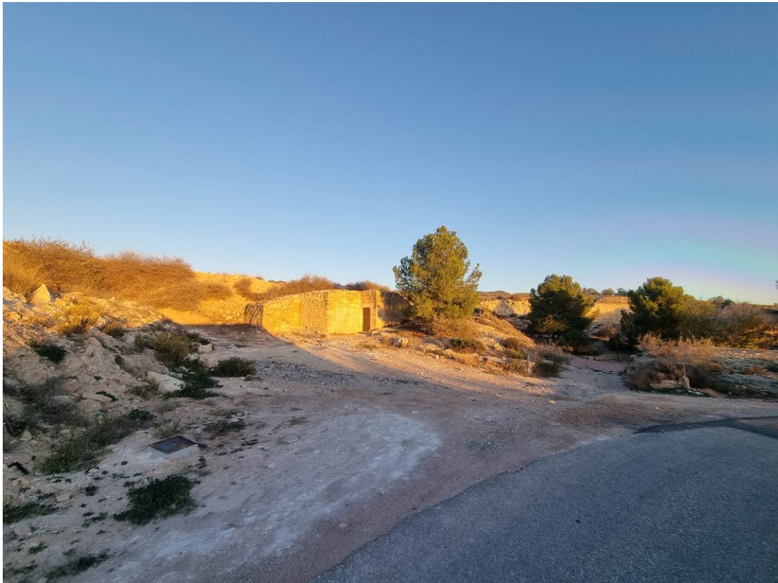
Fig. 93: Vista del refugio una vez restaurado desde el sureste.
