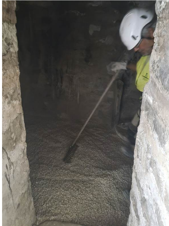
Fig. 67: Proceso de extendido de la grava sobre el suelo de la cámara 1 del refugio.
