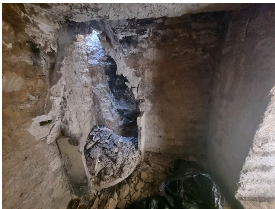
Fig.15: Interior del refugio de cantero nº 6 de la Canyadeta en Monòver. Se observa la chimenea ubicada en la esquina suroeste de la cámara 1, desmantelada. Marzo 2023.
