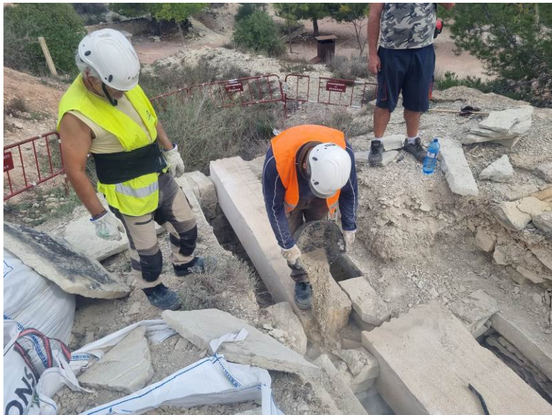
Fig. 54: Proceso de relleno y ajuste de la cubierta tras colocar las nuevas vigas.
