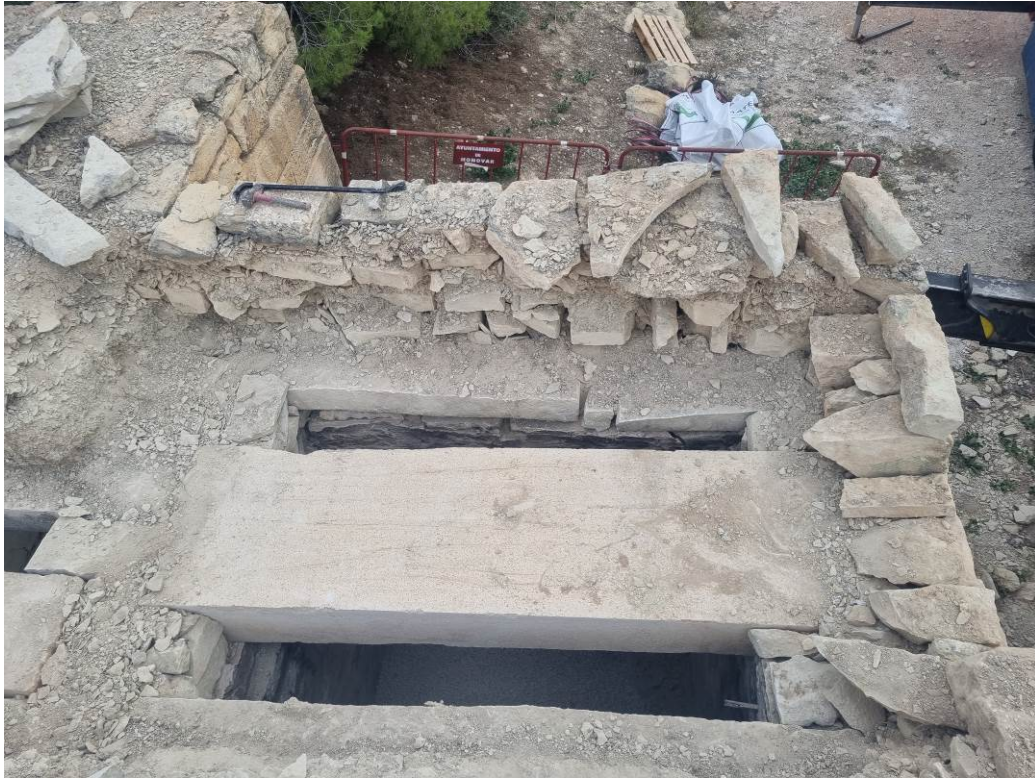
Fig. 53: Otra vista del proceso de reconstrucción de la parte superior de la fachada sur del refugio, sobre la cubierta de la sala 1.
