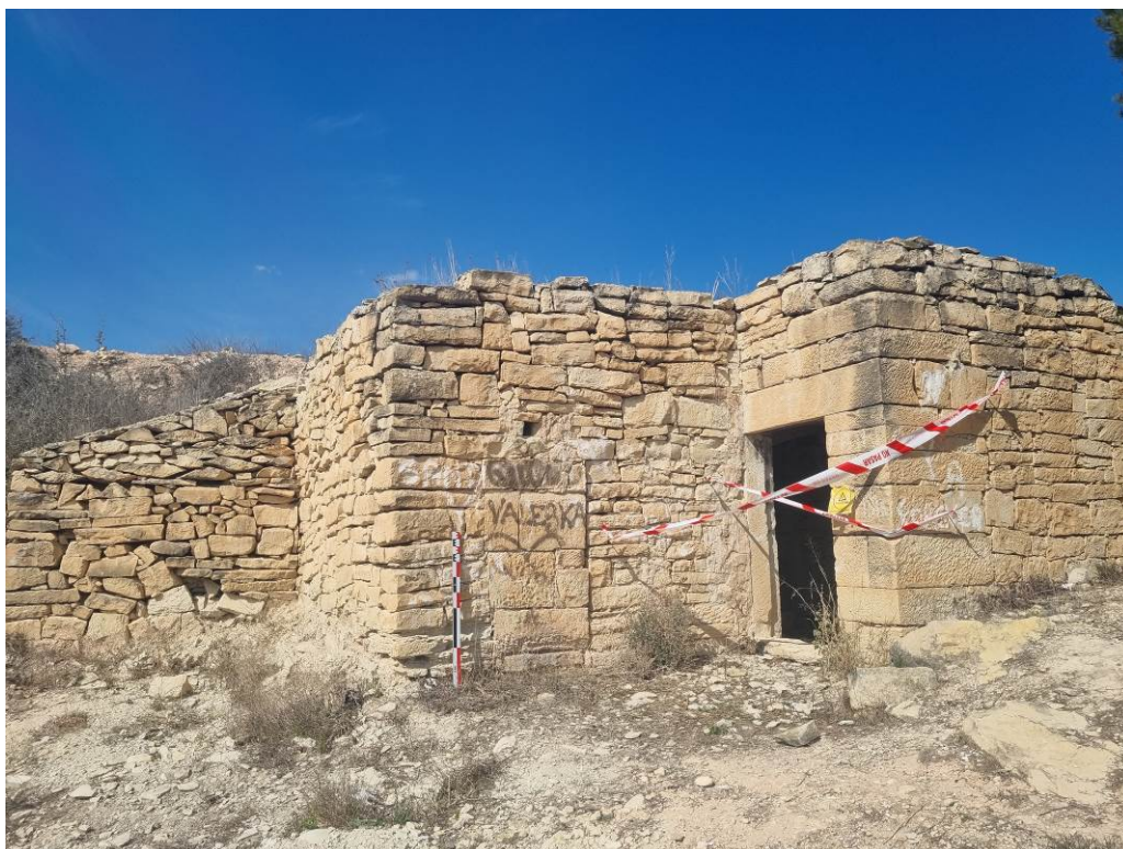
Fig. 10: Exterior del refugio de cantero nº 6 de la Canyadeta en Monòver. Se observa la puerta sellada de la cámara nº 1 y los graffitis en su exterior. Marzo 2023.
