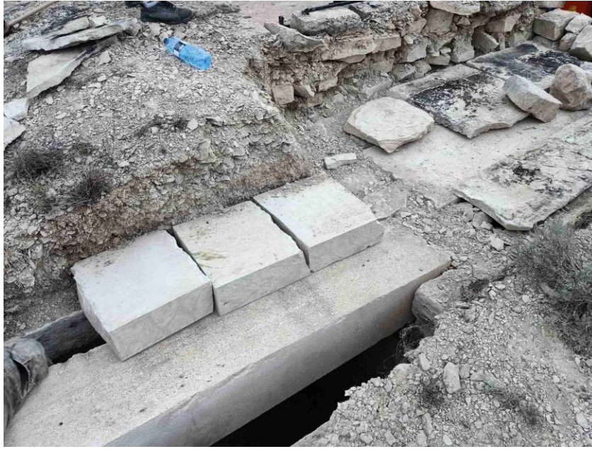
Fig. 73: Proceso de reposición de las vigas y de las losas que se hallaban sobre la cubierta del refugio.
