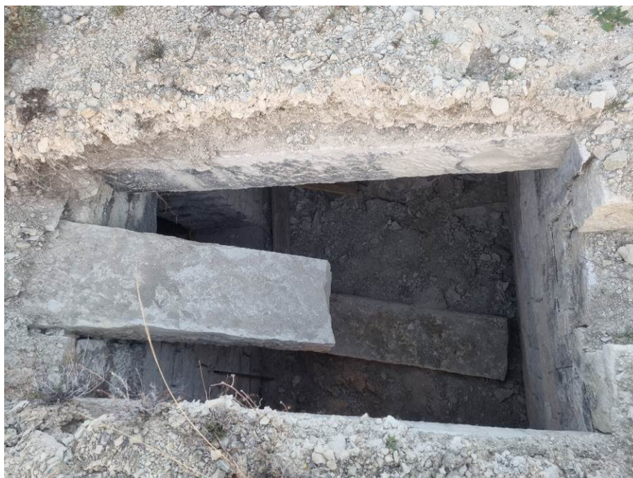
Fig. 26: Vista de la techumbre del refugio al inicio del proceso de limpieza y saneado de la cubierta cedida. 10 octubre 2023.
