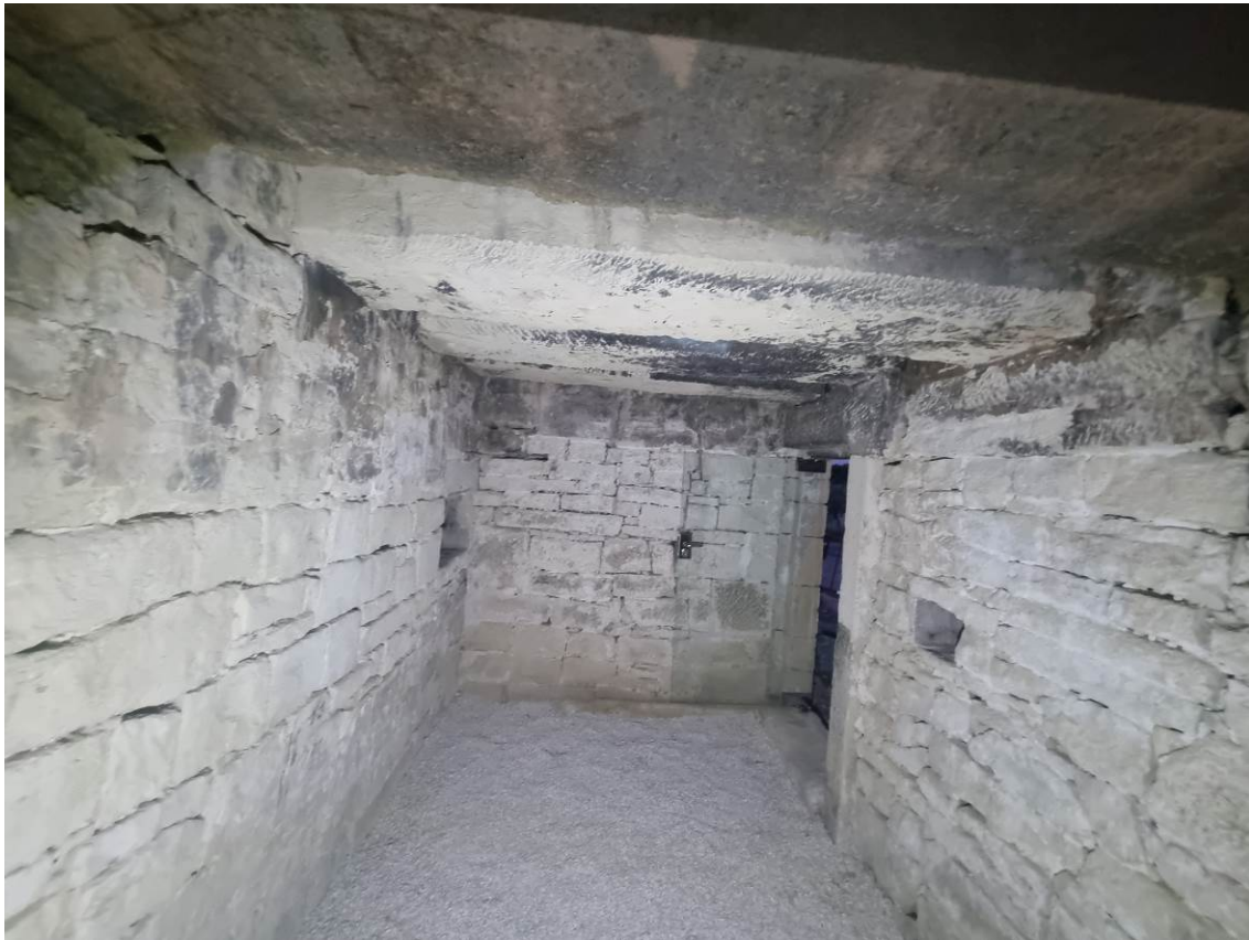
Fig. 81: Interior del refugio, su sala 2, una vez recuperado su pavimento con grava.
