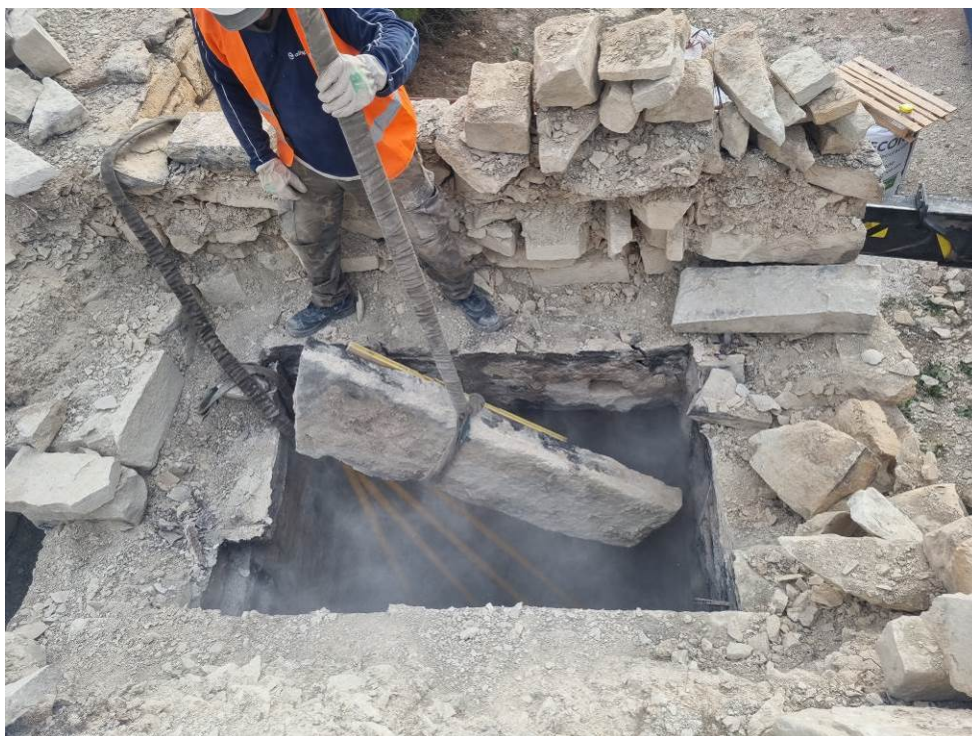
Fig. 41: Proceso extracción de las vigas fisuradas de la cubierta de la cámara 1 del refugio, 19 octubre 2023.
