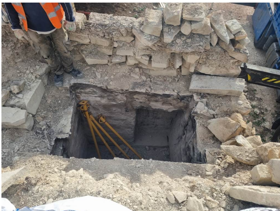
Fig. 42: Cubierta de la cámara 1 del refugio una vez extraídas las vigas fisuradas y las losas de la techumbre. 19 octubre 2023.
