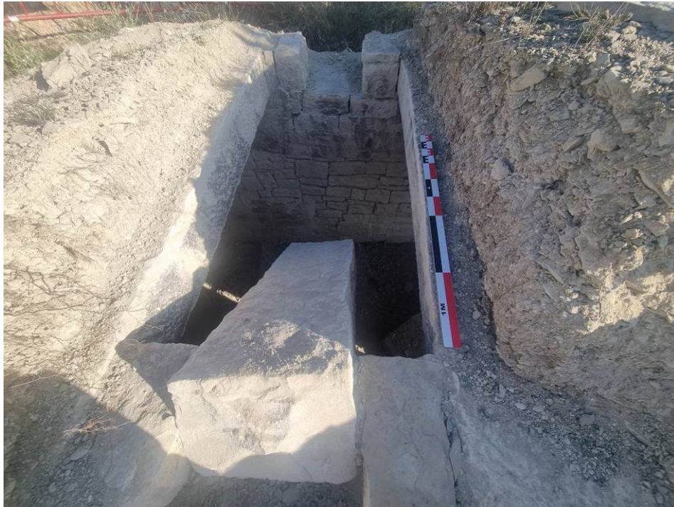
Fig. 33: Vista de la techumbre del refugio tras el saneado de la cubierta, en la zona donde la viga de la cámara 2 había colapsado. 13 octubre 2023.
