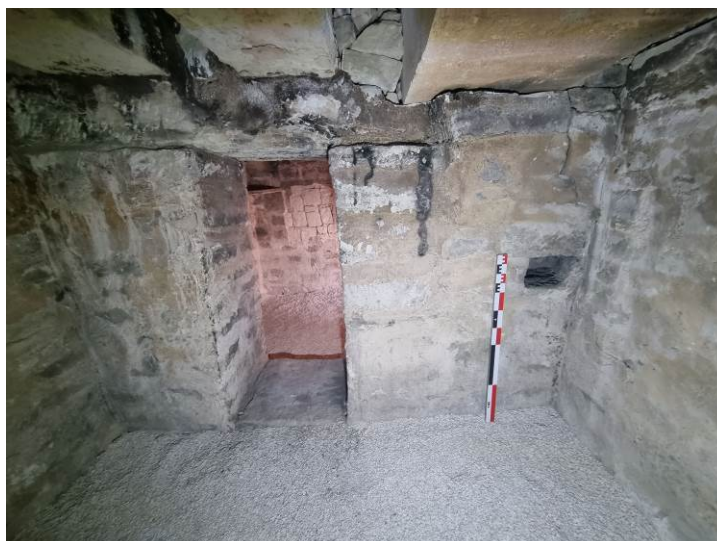
Fig. 77: Interior del refugio, su sala 1, una vez recuperado su pavimento con grava.
