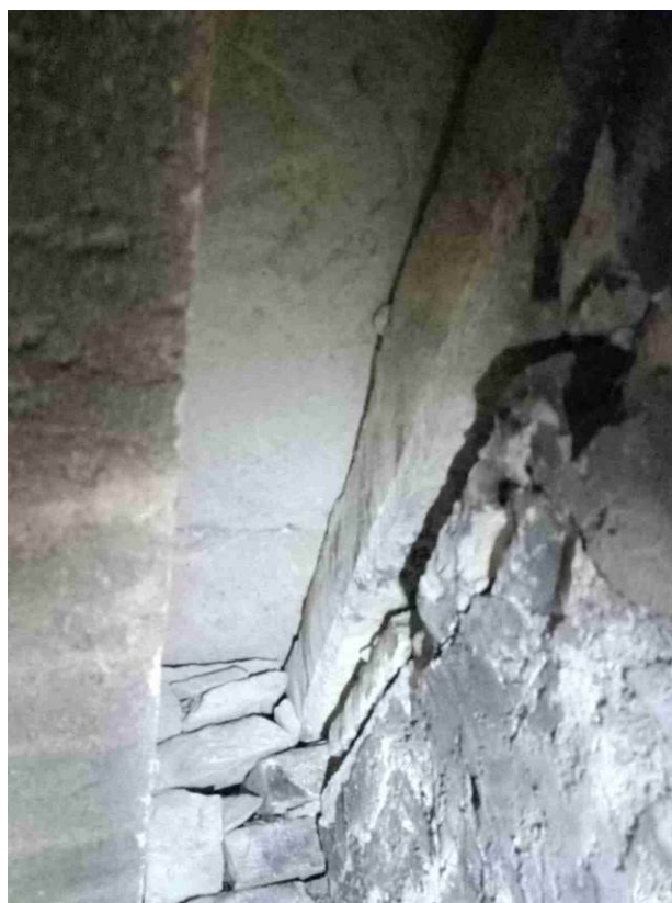
Fig. 62: Detalle de las losas colocadas entre vigas, desde el interior del refugio. Sala o cámara nº 1.
