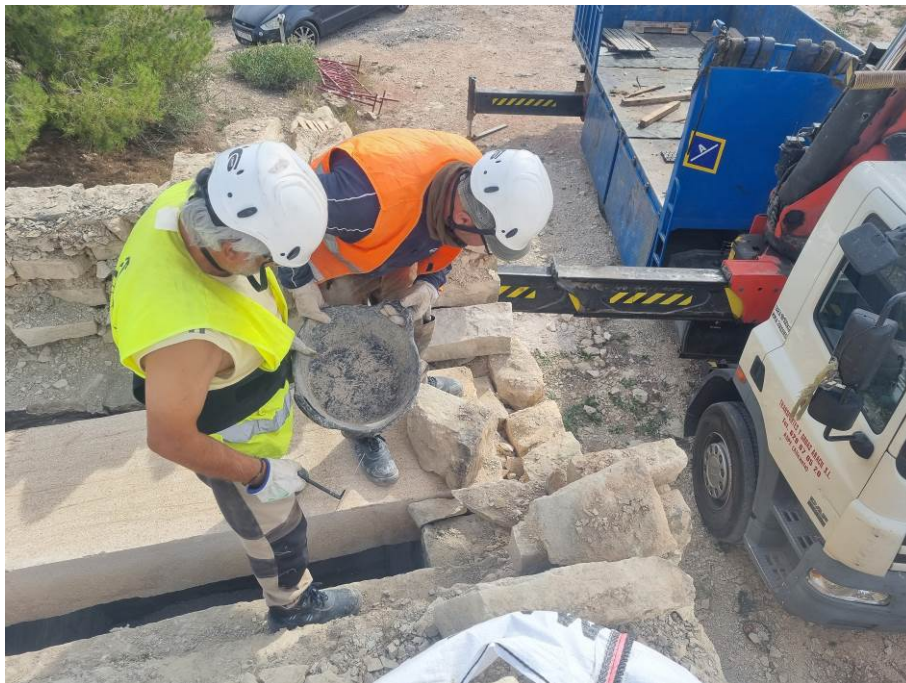
Fig. 52: Proceso de reconstrucción de la parte superior de la fachada sur del refugio.
