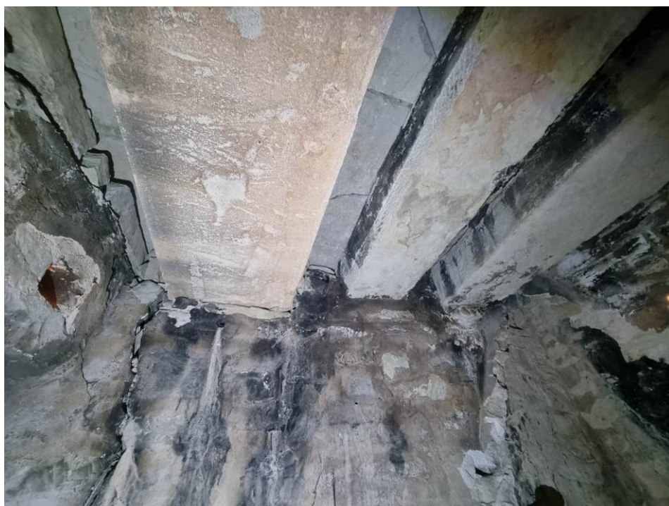
Fig. 102: Aspecto final tras recuperación de techo del refugio con la nueva viga instalada y las losetas colocadas sobre las mismas. Interior cámara nº 1.
