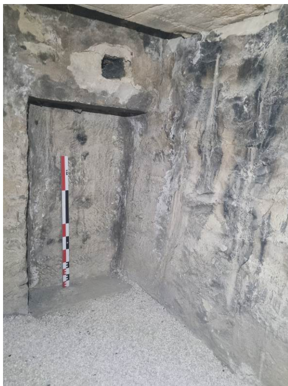
Fig. 103: Aspecto interior cámara 1 en su esquina sureste. Tras finalizar su restauración.
