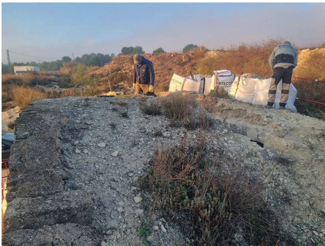
Fig. 27: Trabajos de limpieza y saneado en la techumbre del refugio. 11 octubre 2023.
