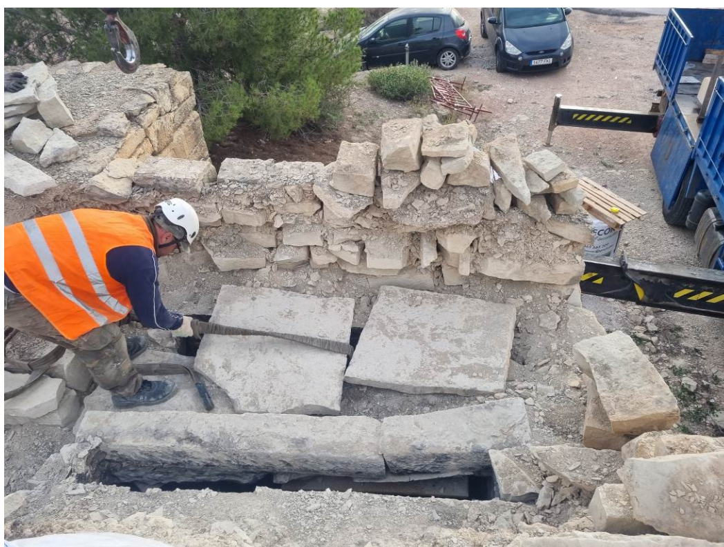
Fig. 38: Proceso extracción de las losas de la cubierta de la cámara 1 del refugio, 19 octubre 2023.
