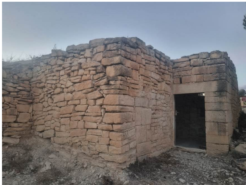
Fig. 84: Vista exterior del refugio tras la instalación de la puerta de vidrio.
