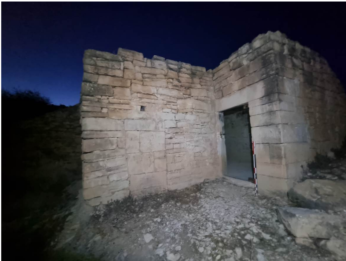
Fig. 106: Vista nocturna del refugio recuperado desde su exterior.
