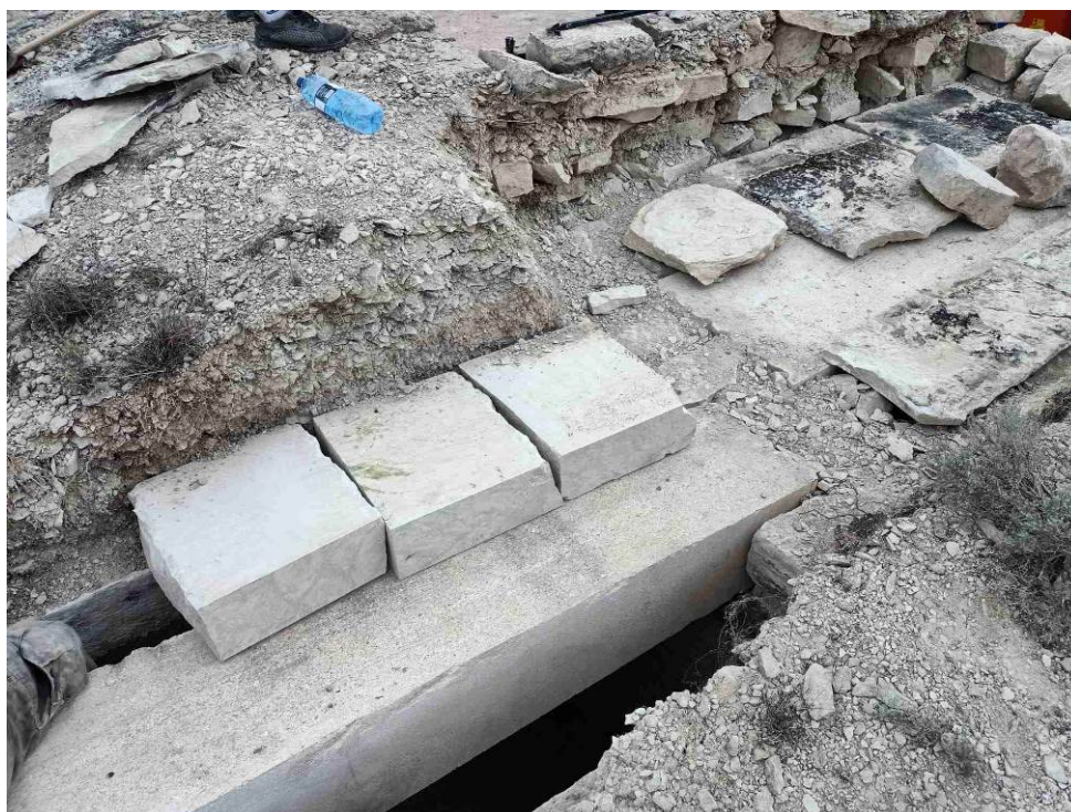
Fig. 56: Proceso de reposición de las losas que se hallaban sobre las vigas de la cubierta de la sala nº 1 y nº 2.
