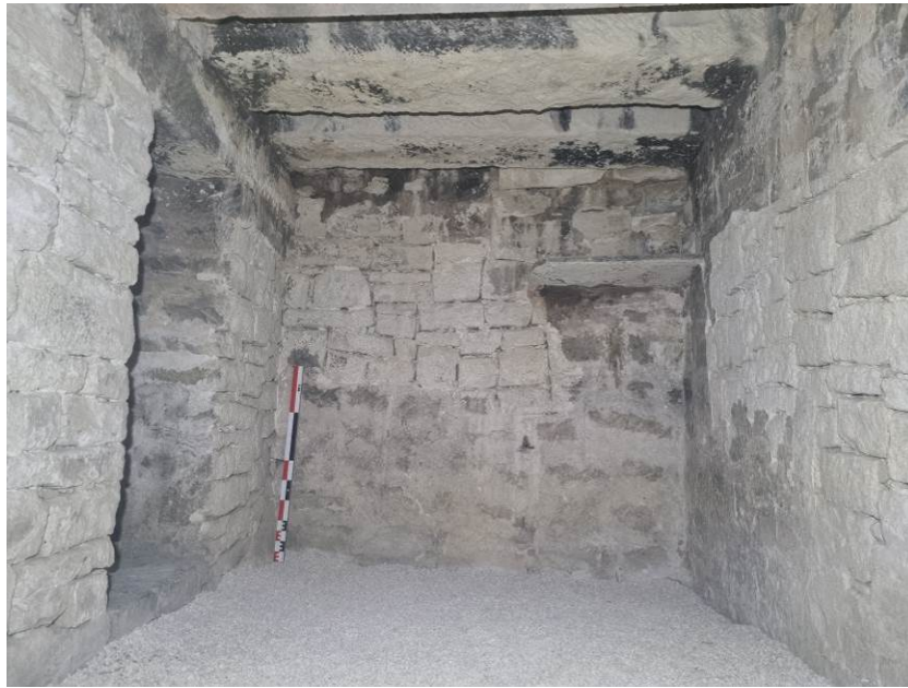
Fig. 83: Otra imagen del aspecto final del interior del refugio, su sala2, una vez recuperado su pavimento con grava y recuperada su cubierta.
