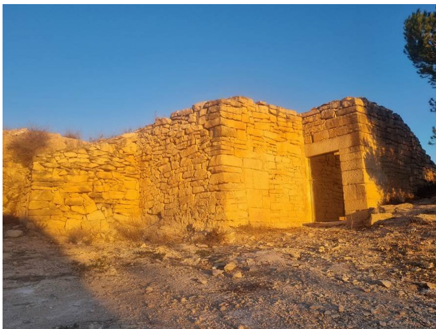
Fig. 72: Aspecto final de la fachada del refugio tras realizar la limpieza de los graffitis y la restauración general del edificio.
