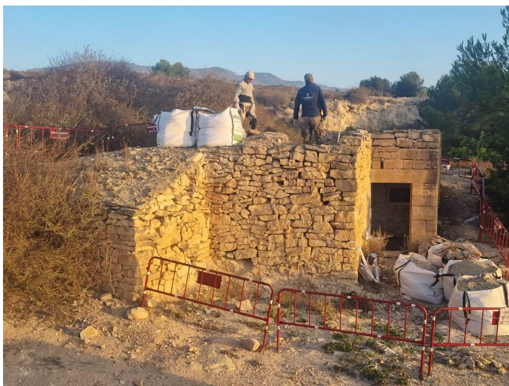
Fig. 28: Trabajos de extracción de tierras y piedras de la techumbre del refugio. Para poder sacar vigas fisuradas y poder reponerlas. 11 octubre 2023.
