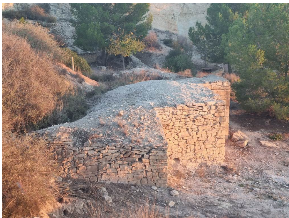
Fig. 76: Otra imagen del aspecto final tras rellenar de ripio y tierra la parte superior del refugio
