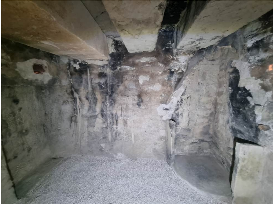
Fig. 65: Interior de la cámara 1 del refugio, una vez colocadas las lajas superiores sobre las vigas.
