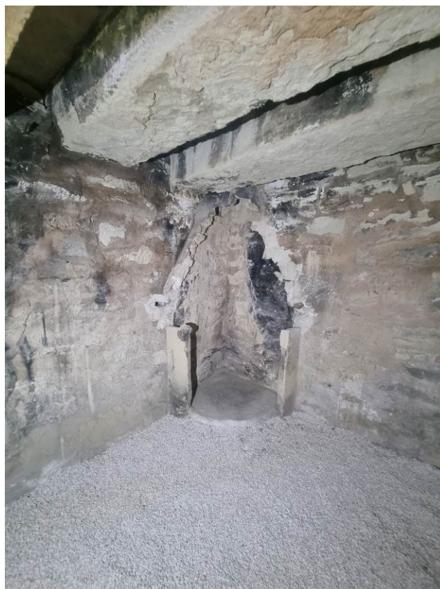
Fig. 79: Interior del refugio, su sala 1, una vez recuperado su pavimento con grava.
