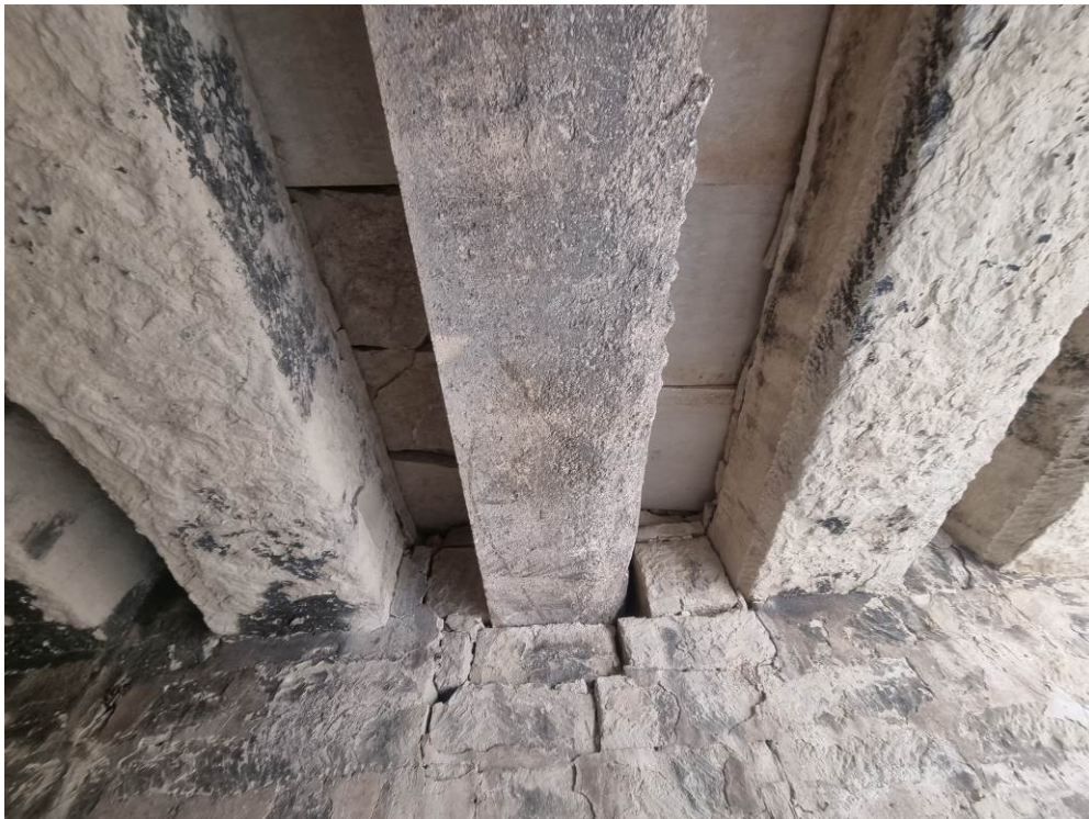
Fig. 64: Otra imagen del interior de la cámara 2 del refugio, una vez colocadas las losas superiores sobre las vigas.
