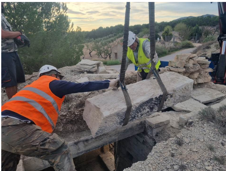
Fig. 35: Extracción por parte de un camión pluma de la viga original fisurada sobre la cámara 2 del refugio. 19 octubre 2023.
