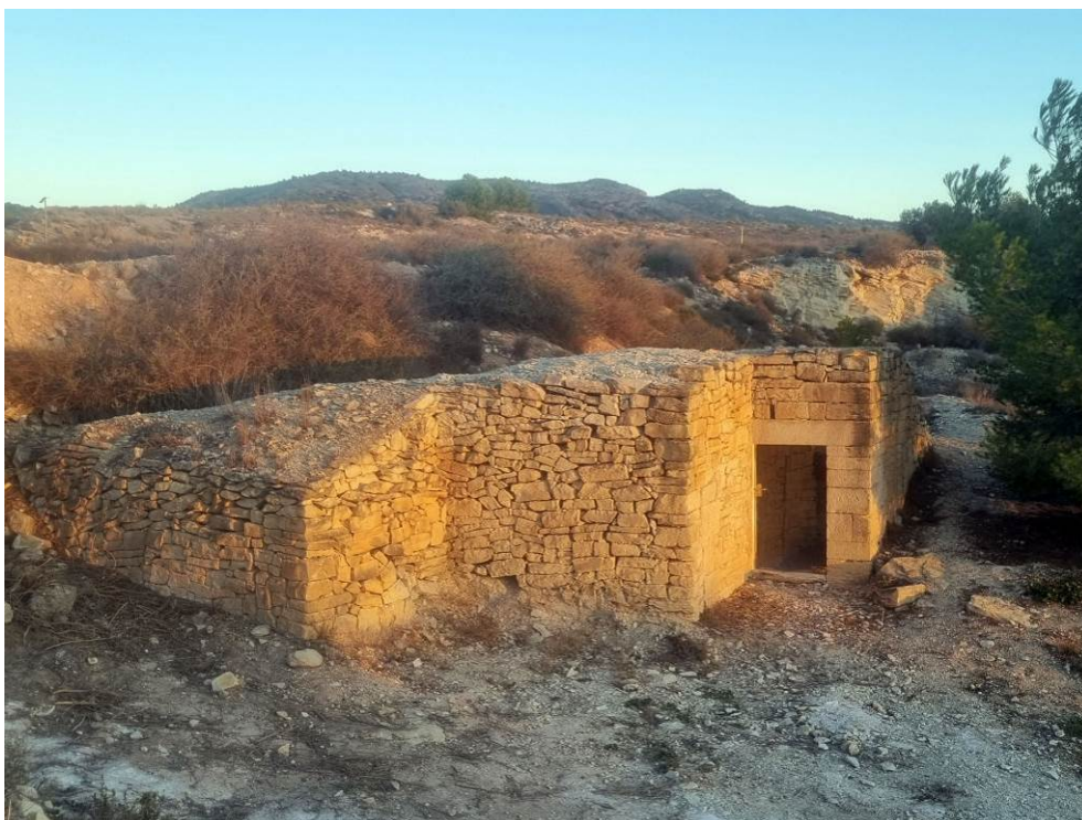
Fig. 107: Aspecto exterior del refugio una vez finalizados sus trabajos de rehabilitación patrimonial.
