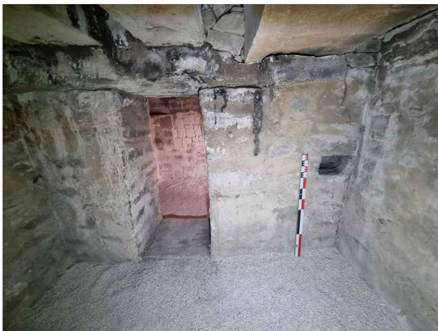
Fig. 101: Parte del techo recuperado y área acceso adintelado a la cámara nº 2 del refugio. Interior cámara nº 1.
