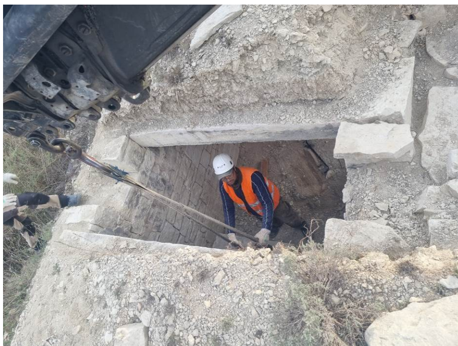
Fig. 36: Extracción por medio de un camión pluma de la otra parte de la viga original fisurada que se encontraba en el interior del refugio, en su cámara 2. 19 octubre 2023.
