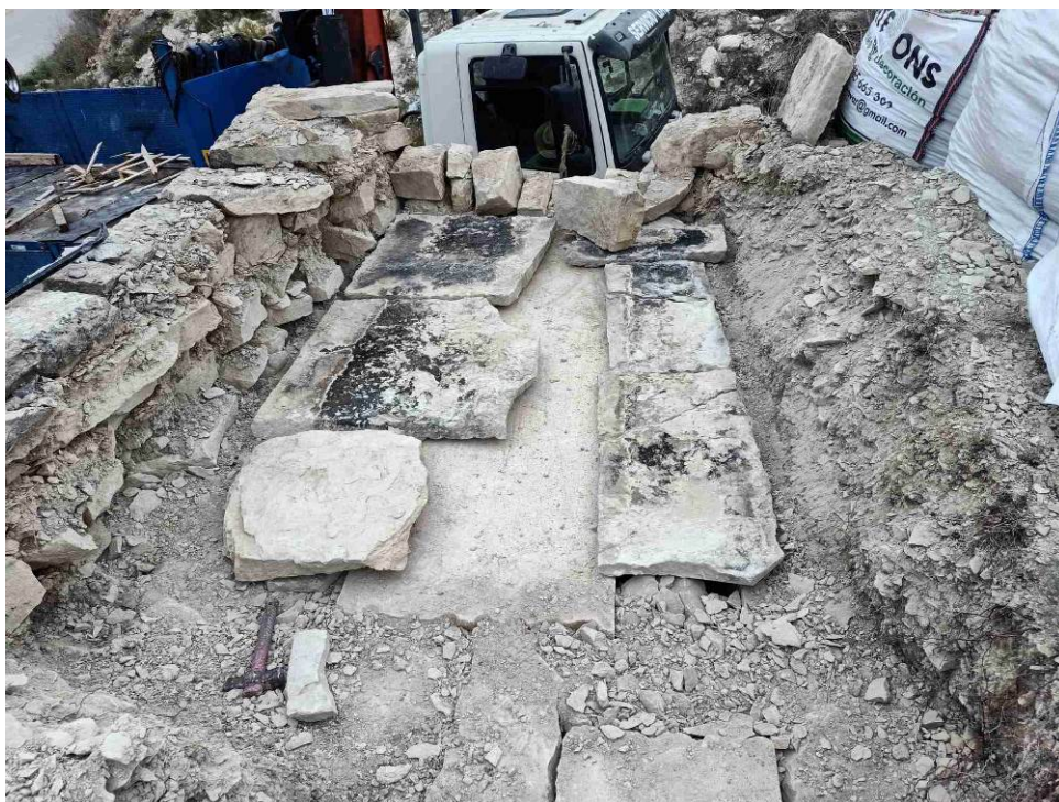
Fig. 55: Proceso de reposición de las losas que se hallaban sobre las vigas de la cubierta de la sala nº 1.
