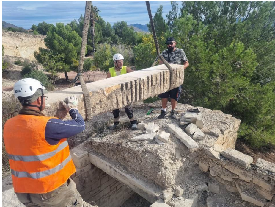
Fig. 46: Preparativos para la colocación, en su lugar, de la nueva viga sobre la cámara 2.
