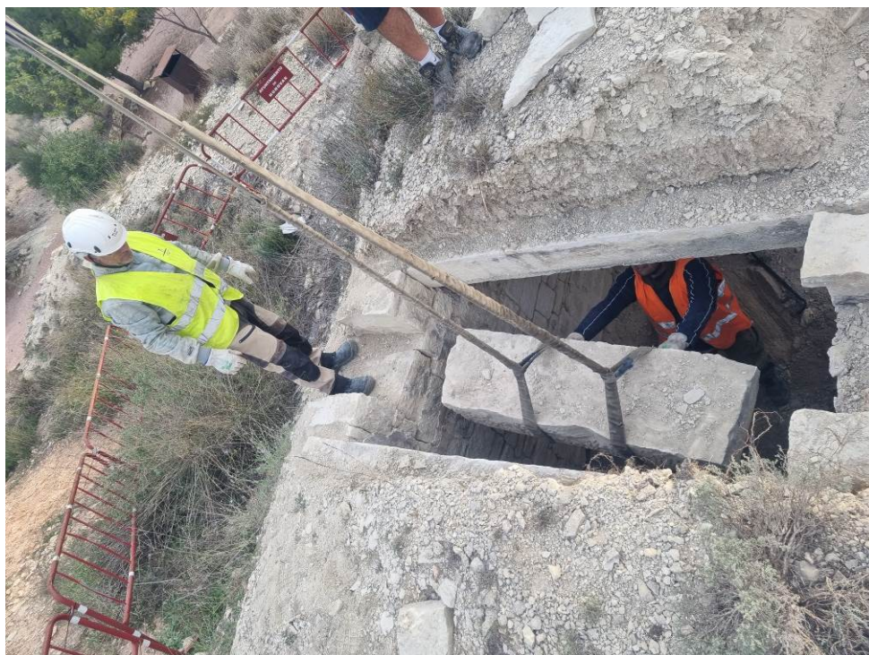
Fig. 37: Proceso extracción de la viga fisurada en la cámara 2 del refugio. 19 octubre 2023.
