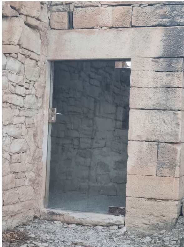
Fig. 85: Detalle puerta de vidrio instalada para acceder al refugio.
