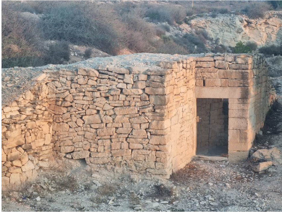
Fig. 105: Aspecto del refugio tras su recuperación patrimonial
