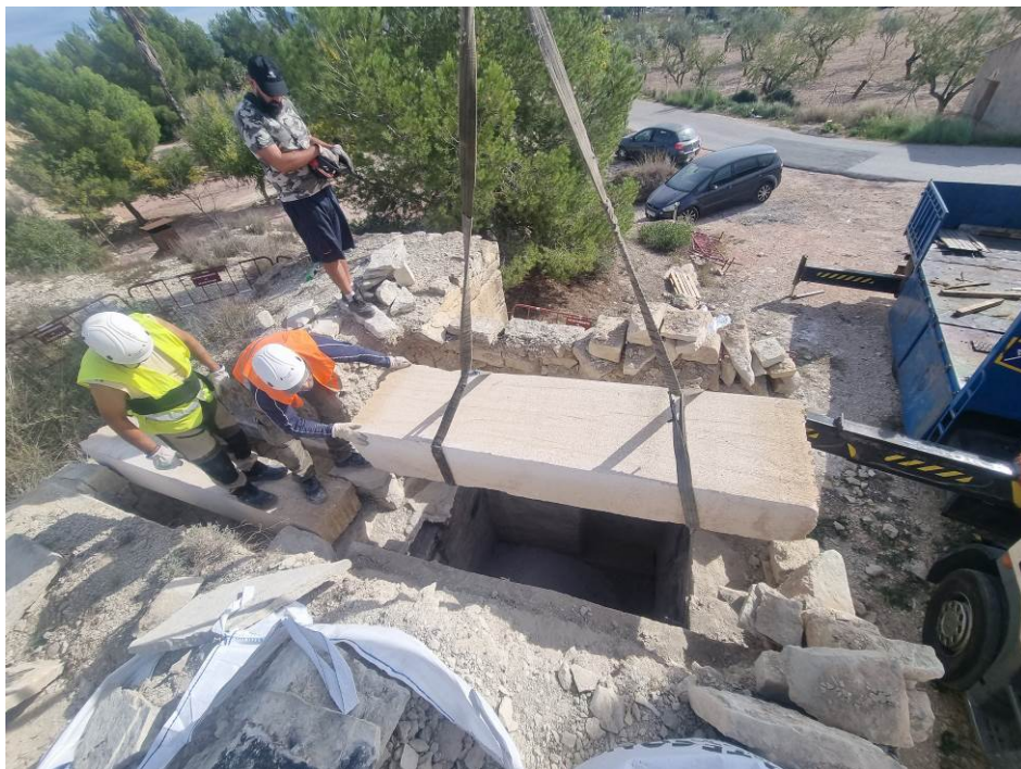
Fig. 50: Proceso de colocación de la nueva viga para la sala 1 del refugio.
