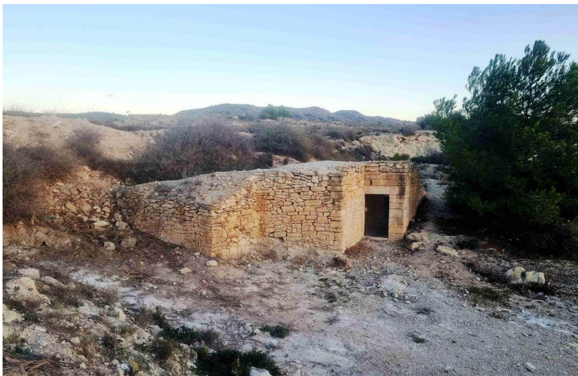
Fig. 88: Aspecto del refugio desde el sur, una vez finalizada su restauración.
