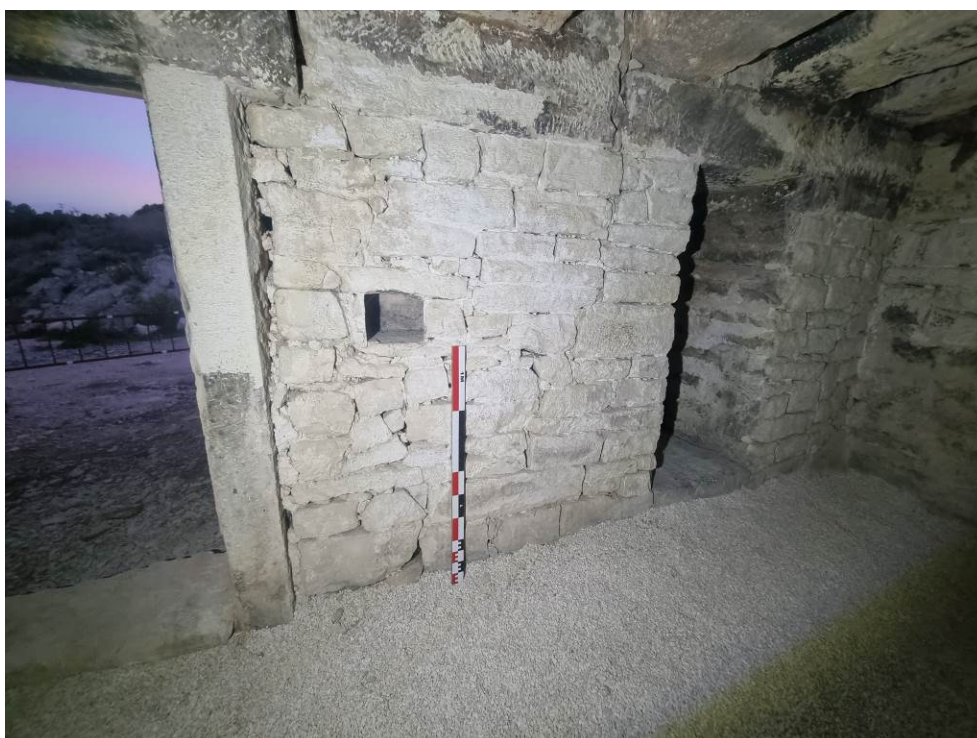
Fig. 96: Vista del interior del refugio, en concreto su sala nº 2, tras su rehabilitación. Parte acceso y paso a sala nº 1.
