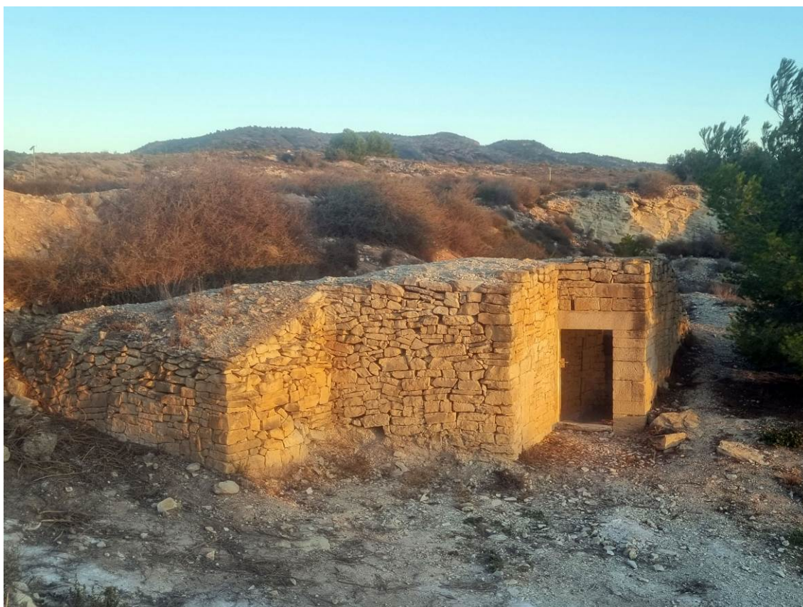
Fig. 90: Aspecto final del refugio una vez restaurado.
