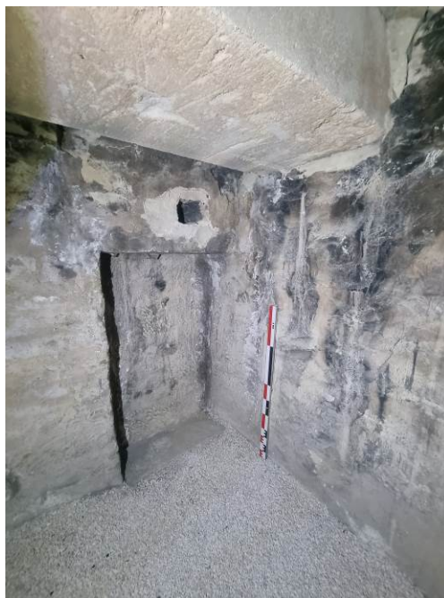
Fig. 78: Interior del refugio, su sala 1, una vez recuperado su pavimento con grava.
