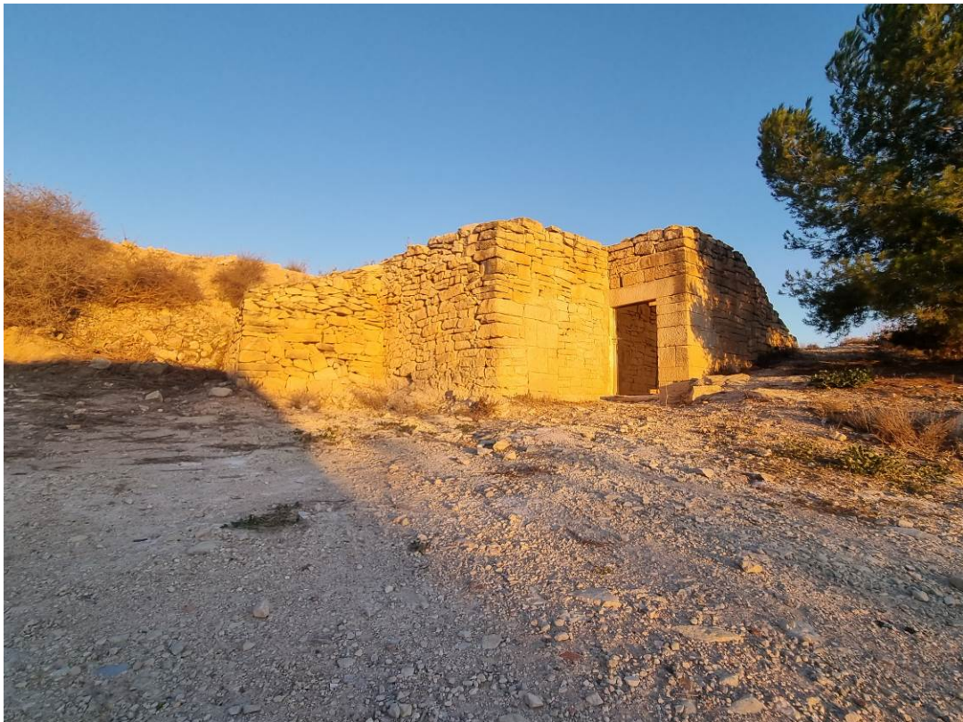
Fig. 92: Vista desde el sureste del refugio una vez restaurado.
