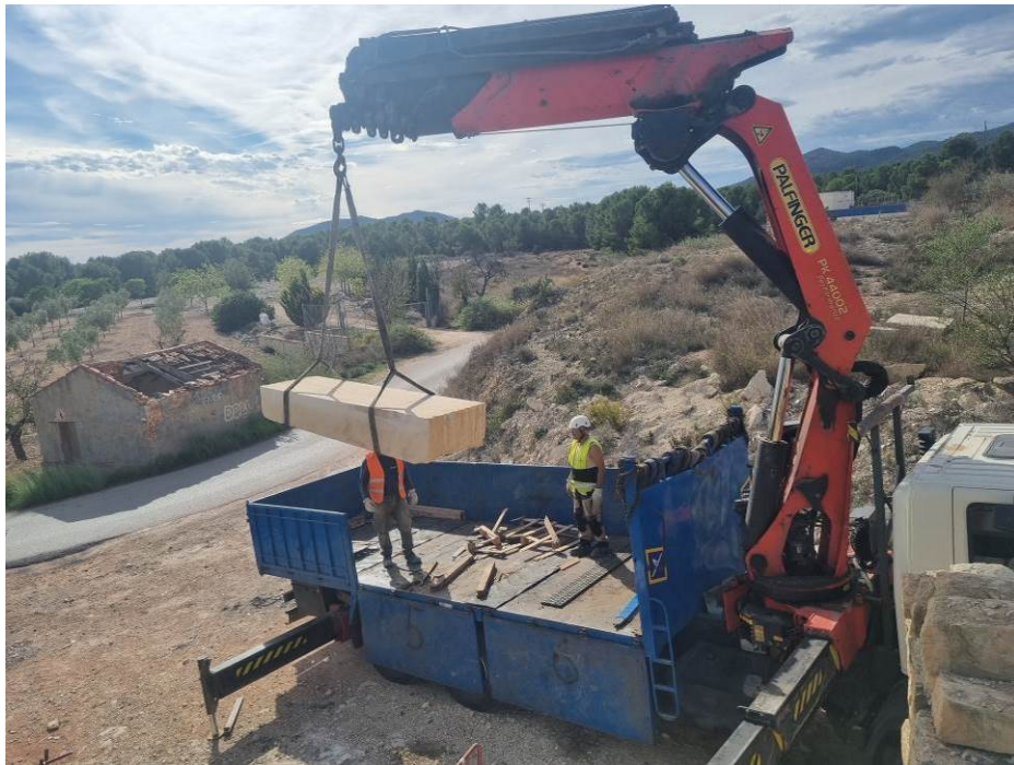
Fig. 49: Traslado de la nueva viga para la sala 1 del refugio. Viga de mayor envergadura que la anterior, con una anchura de 65 cm.
