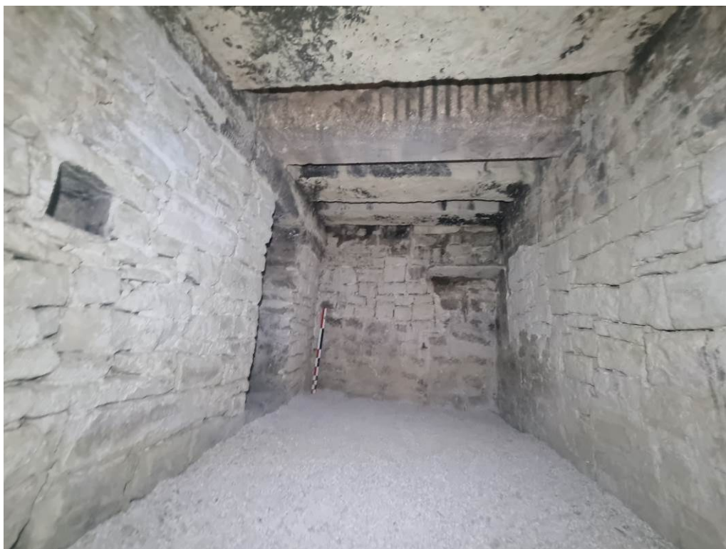
Fig. 95: Vista del interior del refugio, en concreto su sala nº 2, tras su rehabilitación.
