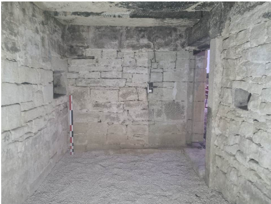
Fig. 94: Vista del interior del refugio en su área de acceso, se observa alcena y puerta.
