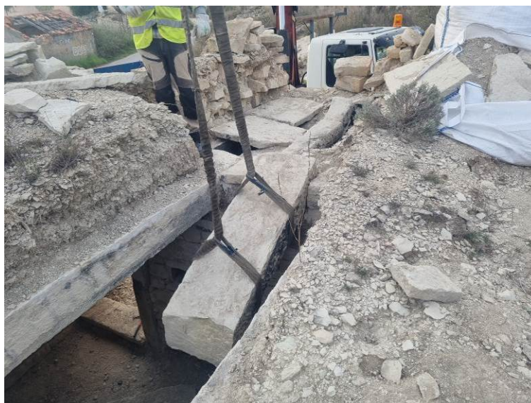
Fig. 34: Extracción por medios mecánicos de parte de la viga original fisurada sobre la cámara 2 del refugio. 19 octubre 2023.
