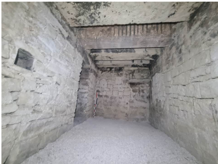
Fig. 82: Aspecto final del interior del refugio, su sala2, una vez recuperado su pavimento con grava y recuperada su cubierta.
