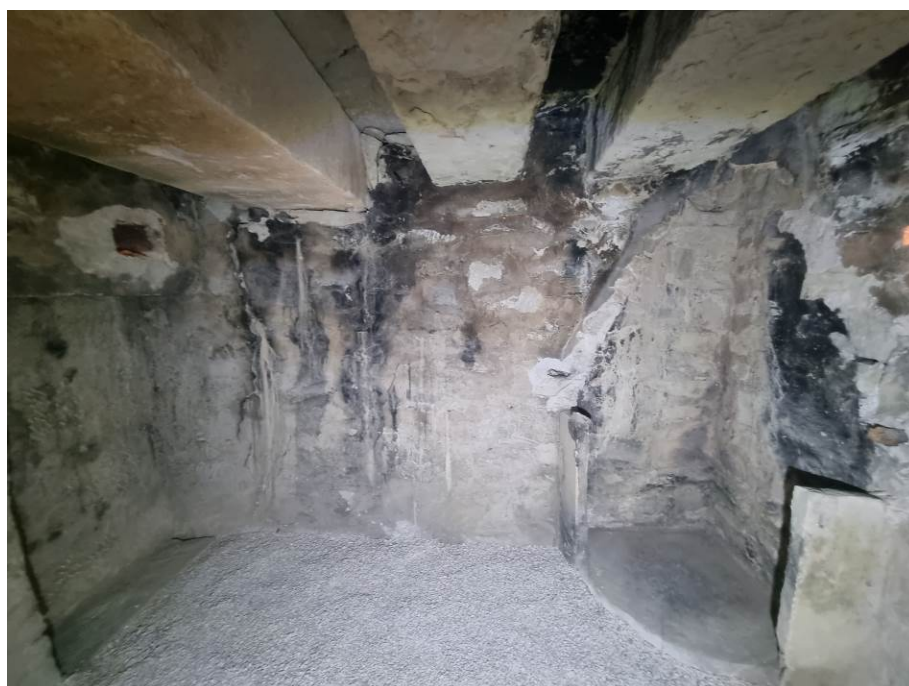
Fig. 100: Detalle aspecto final de parte del techo recuperado en la sala o cámara nº 1.
