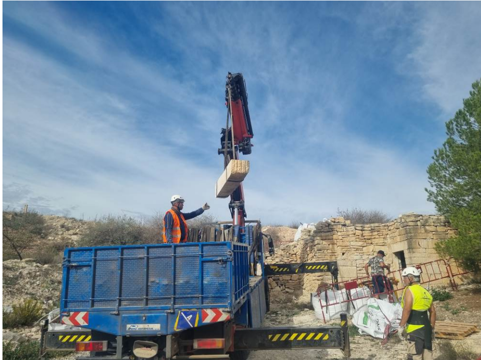
Fig. 45: Traslado de la nueva viga para la sala 2 del refugio.
