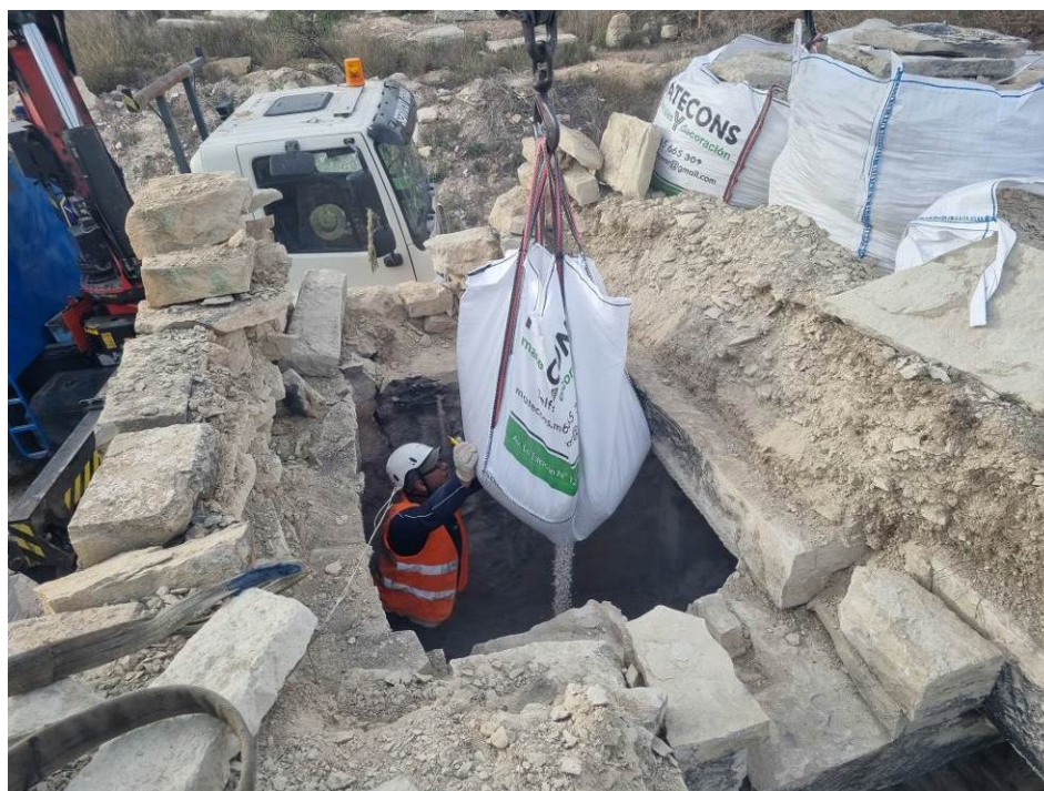
Fig. 44: Introducción de grava en el interior del refugio para homogenizar el suelo del edificio.
