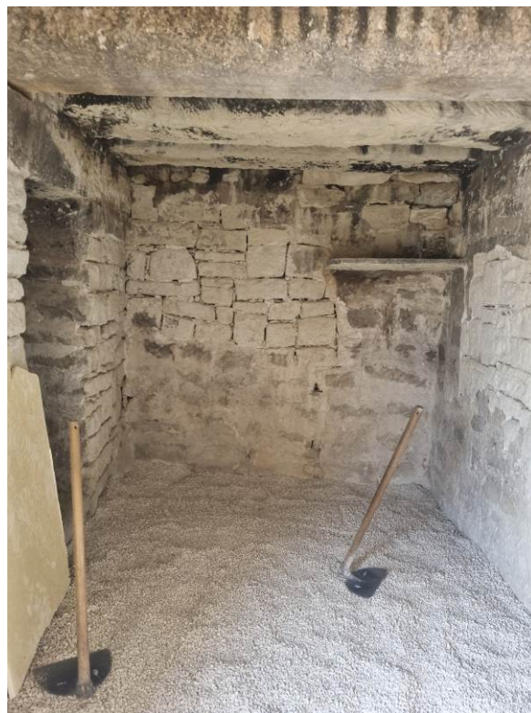
Fig. 68: Proceso de extendido de la grava sobre el suelo de la cámara 2 del refugio. 19 octubre 2023.
