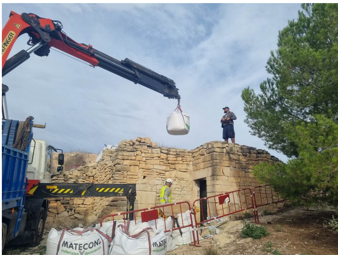
Fig. 43: Introducción de sacas de grava en el interior del refugio para homogenizar el suelo del edificio.
