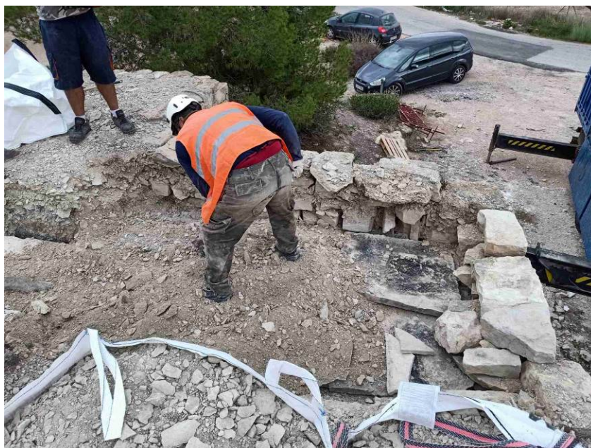
Fig. 59: Proceso de extendido de la tierra y ripio, sobre la cubierta de vigas y losas repuestas.
