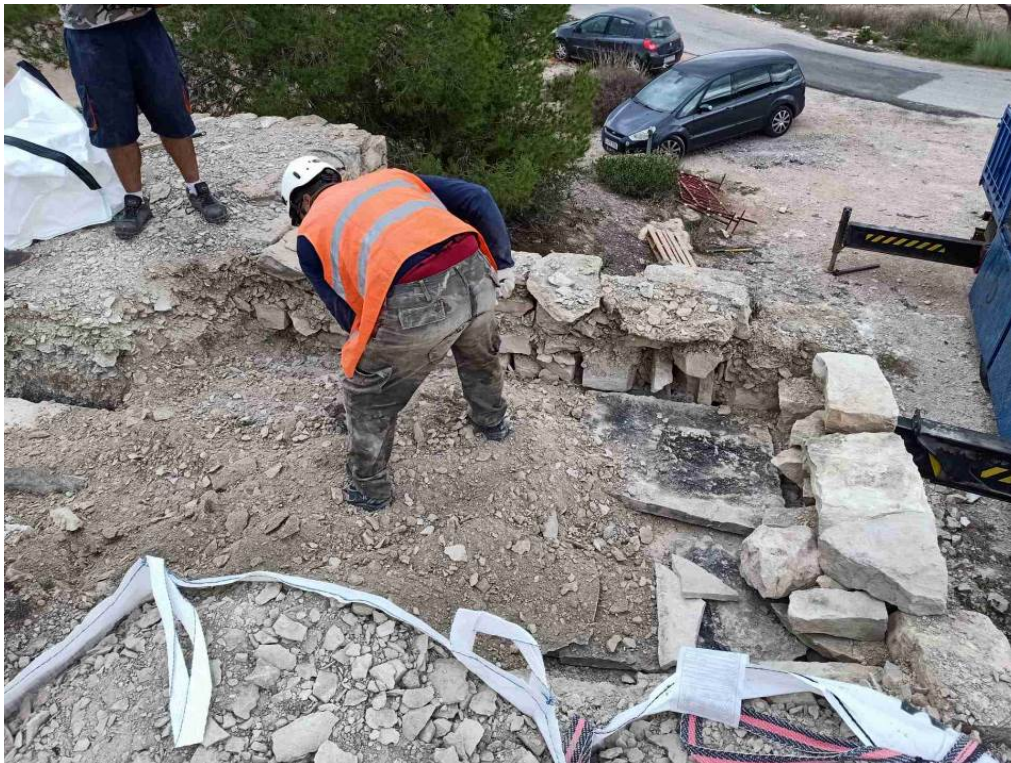
Fig. 74: Proceso de reposición de la tierra y el ripio que se hallaban sobre la cubierta del refugio.
