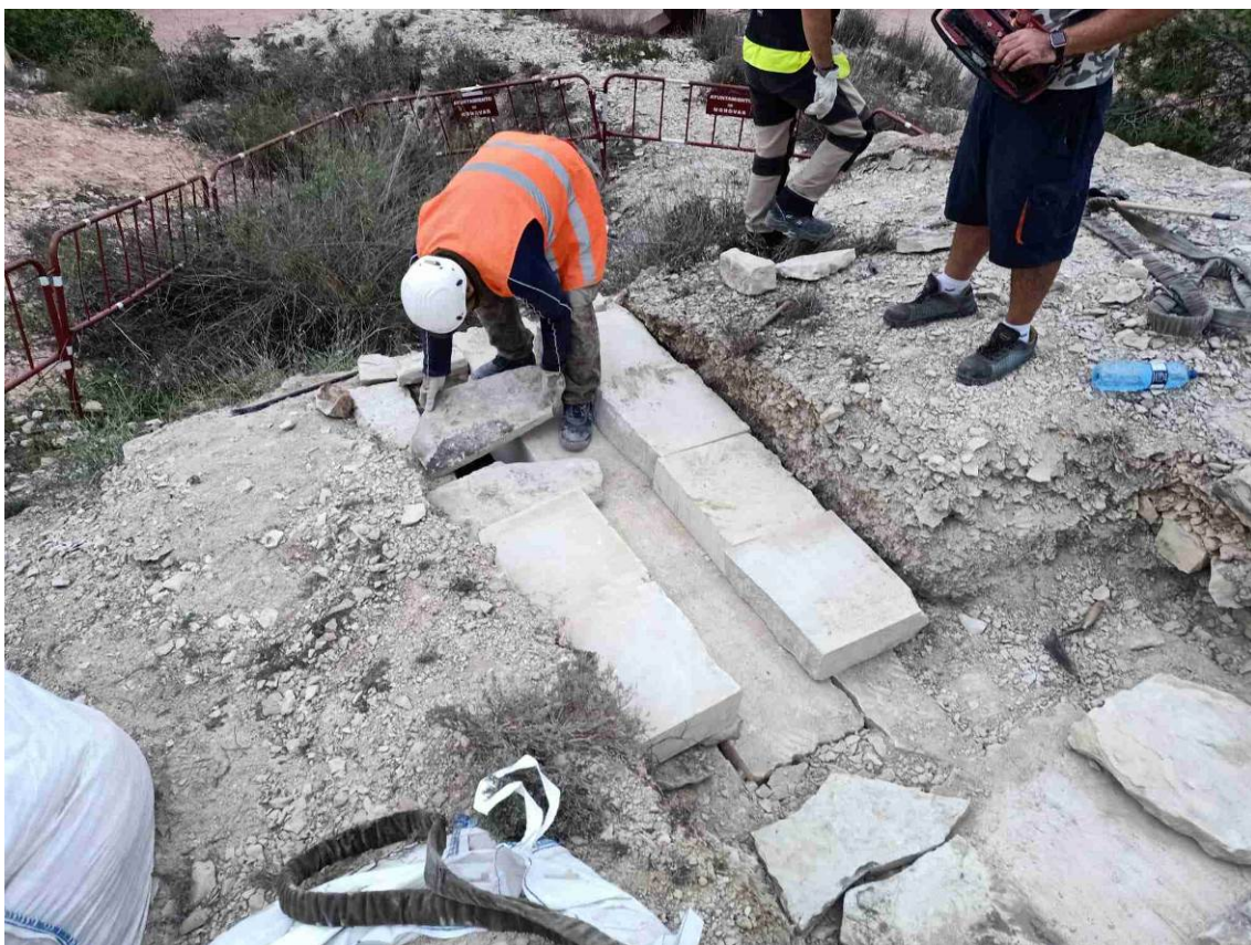
Fig. 57: Proceso de reposición de las losas que se hallaban sobre las vigas de la cubierta de la sala nº 2.
