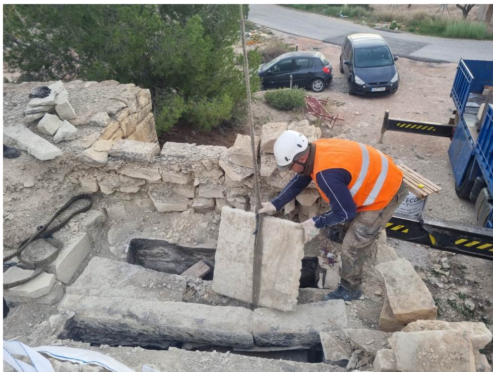
Fig. 39: Proceso extracción de las losas de la cubierta de la cámara 1 del refugio, 19 octubre 2023.
