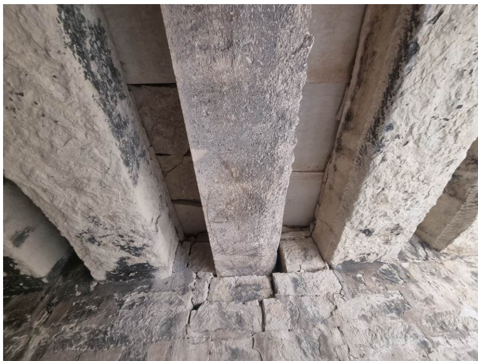
Fig. 98: Aspecto del techo del refugio tras su rehabilitación. Vigas y losas de la techumbre en la sala 2.
