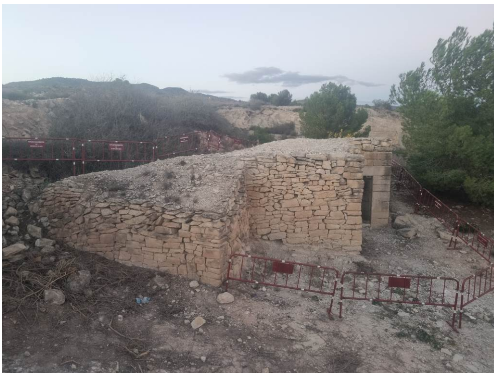
Fig. 75: Aspecto final tras rellenar de ripio y tierra la parte superior del refugio
