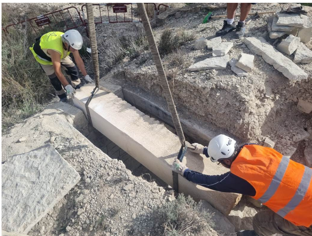
Fig. 47: Colocación de la nueva viga sobre la cámara 2.
