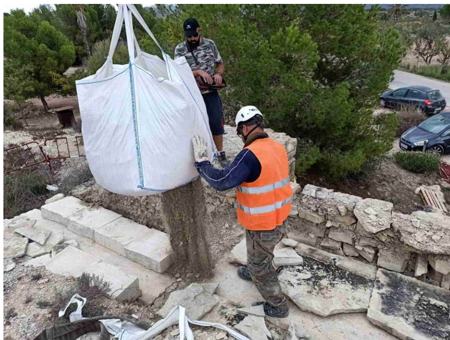
Fig. 58: Proceso de rellenado de la cubierta con la tierra y ripio, anteriormente extraída de la techumbre del refugio.
