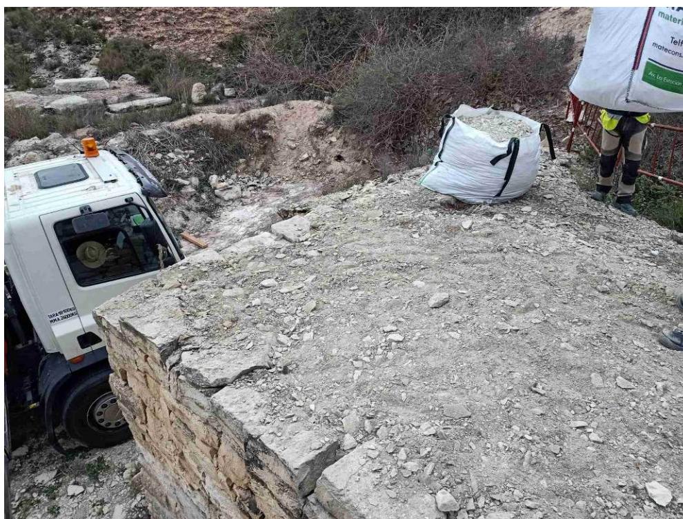
Fig. 60: Finalización del proceso de extendido de la tierra y ripio, sobre la cubierta de vigas y losas repuestas.
