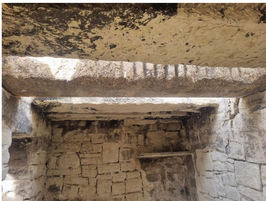
Fig. 48: Vista del interior del refugio una vez colocada la nueva viga en la cámara 2.
