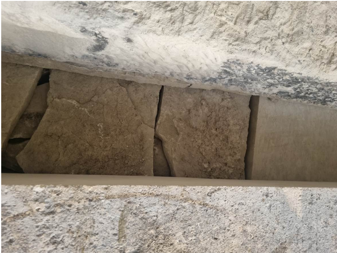
Fig. 63: Cubierta interior sala 2, una vez colocadas las lajas sobre las vigas.
