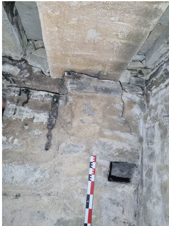
Fig. 66: Interior de la cámara 1 del refugio, una vez colocadas las lajas superiores sobre las vigas.
