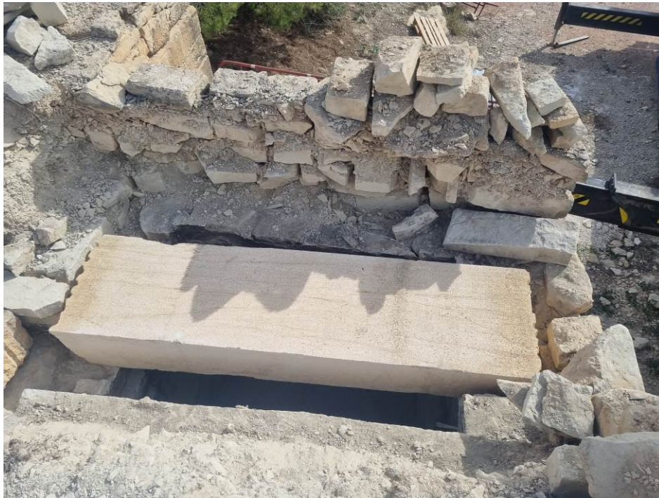
Fig. 51: Nueva viga, de grandes dimensiones, ya colocada en la cubierta de la sala 1 del refugio.
