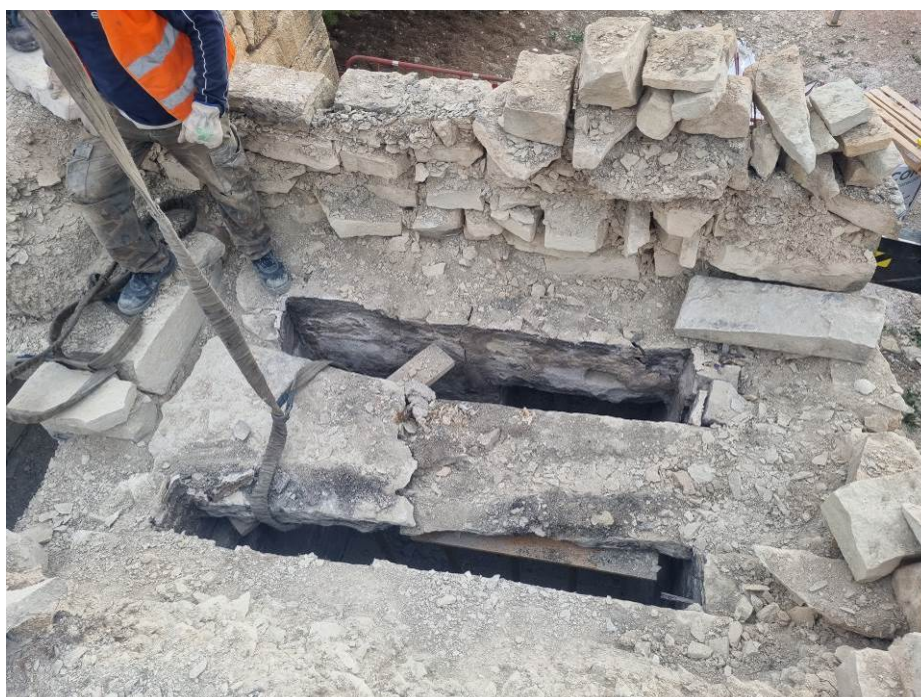
Fig. 40: Proceso extracción de las vigas fisuradas de la cubierta de la cámara 1 del refugio, 19 octubre 2023.
