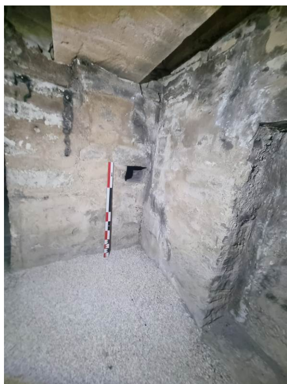
Fig. 104: Aspecto interior cámara 1 en su esquina noreste. Tras finalizar su restauración.
