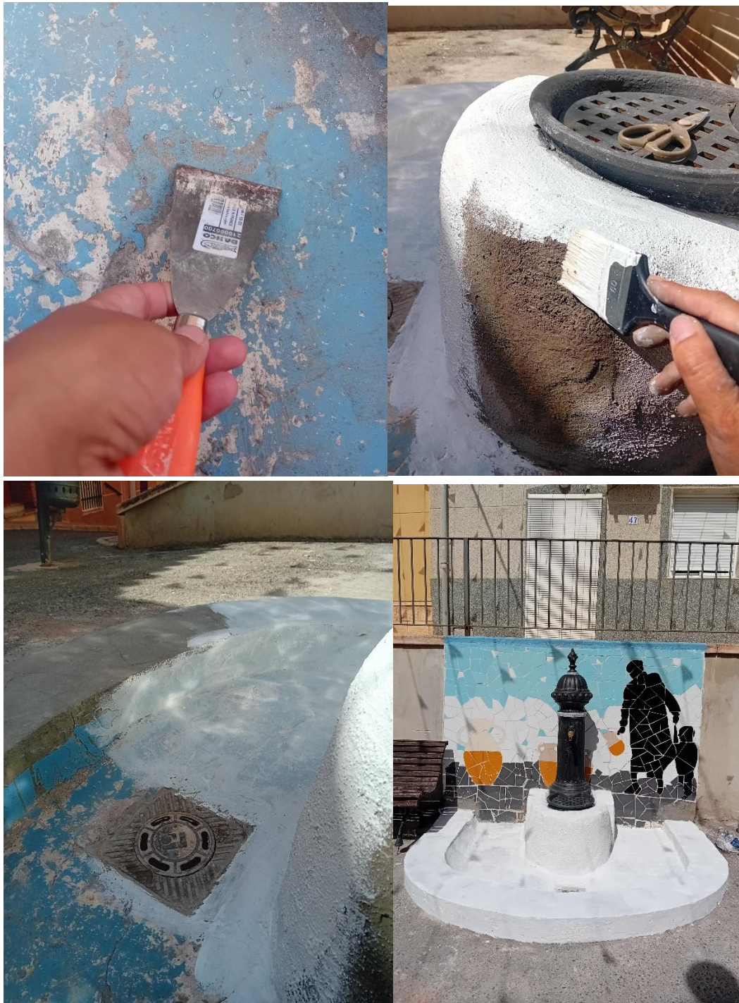
Fig. 28: Tratamiento y acabado pedestal y explanada.
