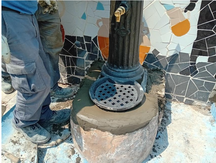
Figura 26; Reconstrucción pedestal.
