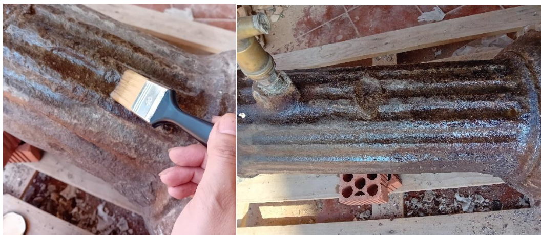
Fig. 16; aplicación del ácido tánico.
