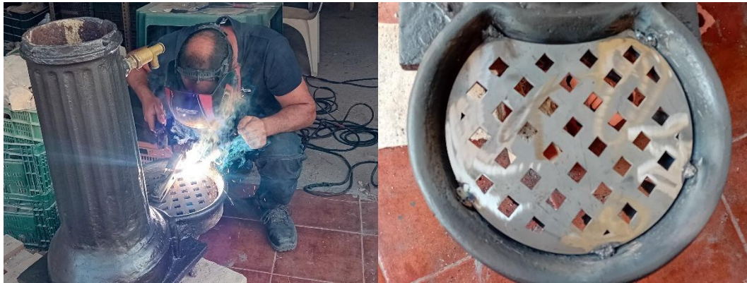
Fig. 23: colocación nueva rejilla.
