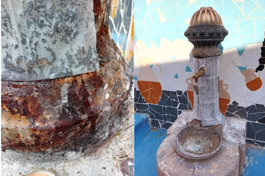
Fig. 12: Proceso de protección, engasado.
