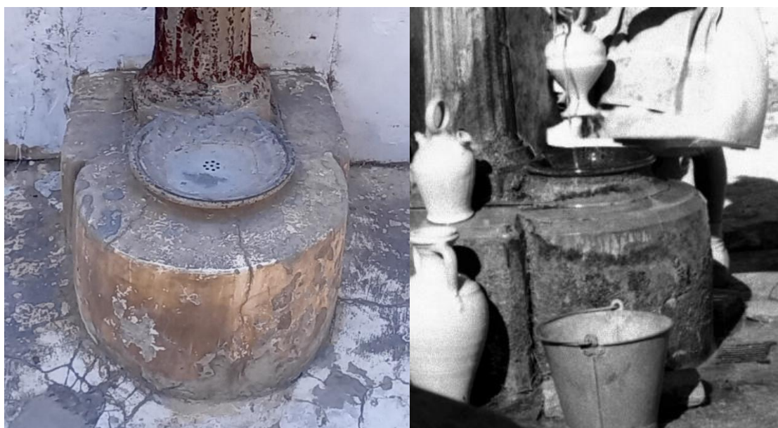
Fig. 7: Detalle del revestimiento de la piedra 2 .
