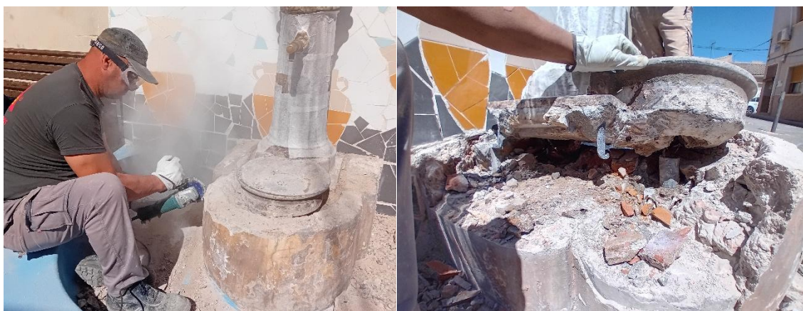
Fig. 13: Proceso de extracción de la fuente de su ubicación.
