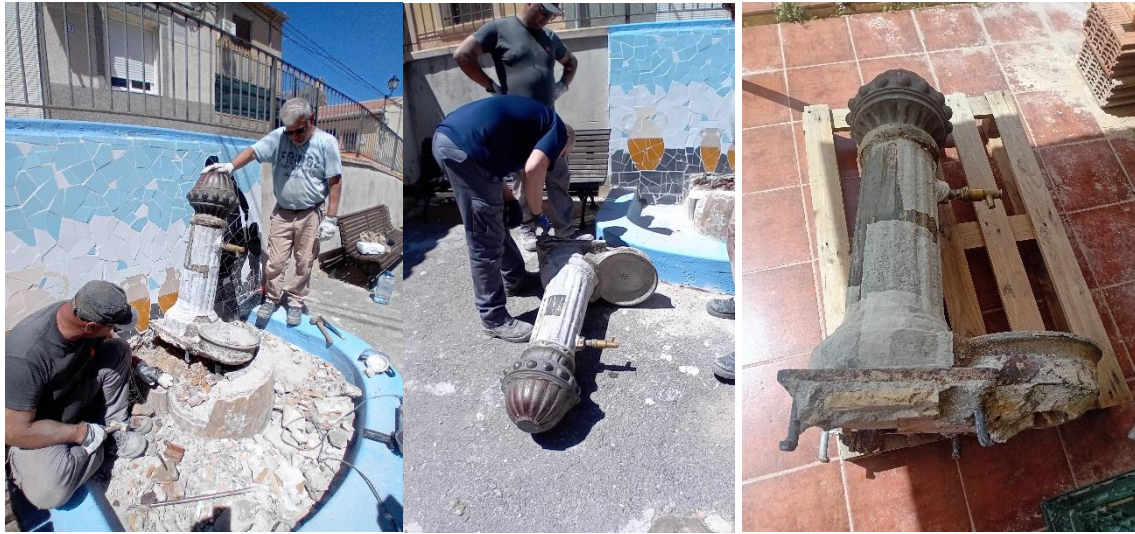
Fig. 14: Proceso de extracción de la fuente de su ubicación.
