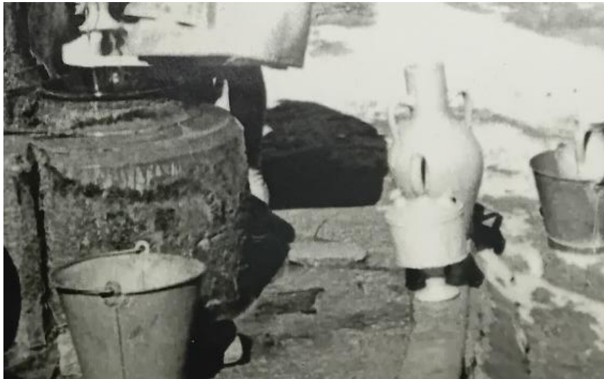
Fig. 8: Detalle de la forma y altura del murete que formaba la explanada de desagüe original 3 .
