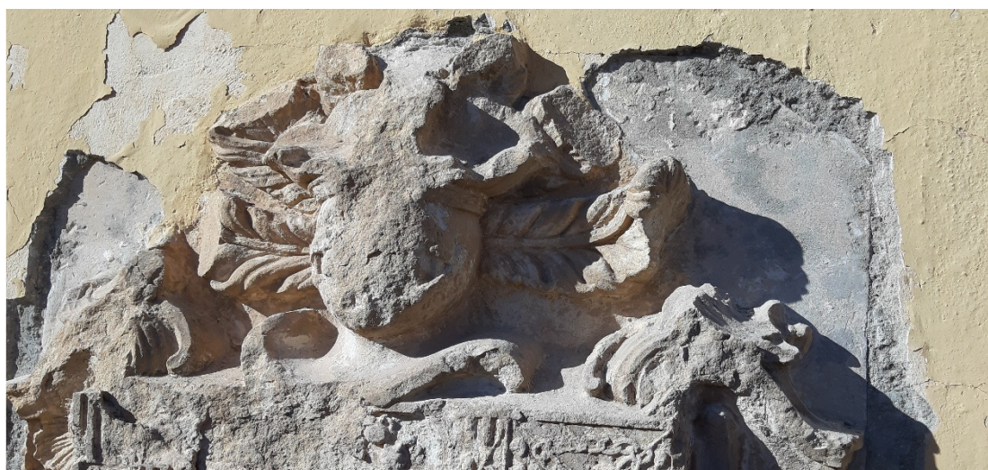
Fig.3. Detalle del escudo y su entorno de cemento
