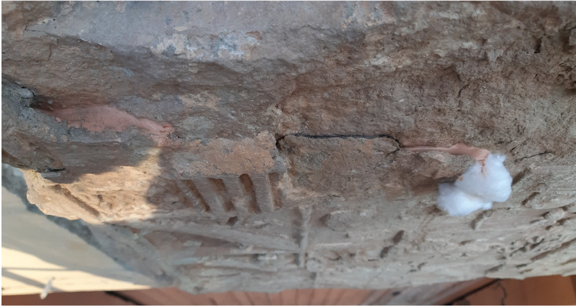
Fig. 9. Aplicación de morteros de inyección a través de fisuras y oquedades hasta colmatación del hueco
