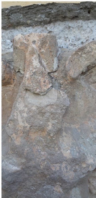
Fig.10 y 11. Pegado de fragmentos con adhesivo epoxídico araldit piedra.
