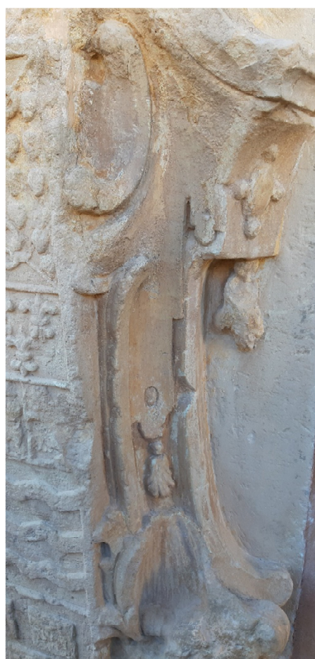
Fig. 14 y 15. Aplicación de una pátina de agua de cal y pigmentos tierra y conservación de restos pictóricos originales.
