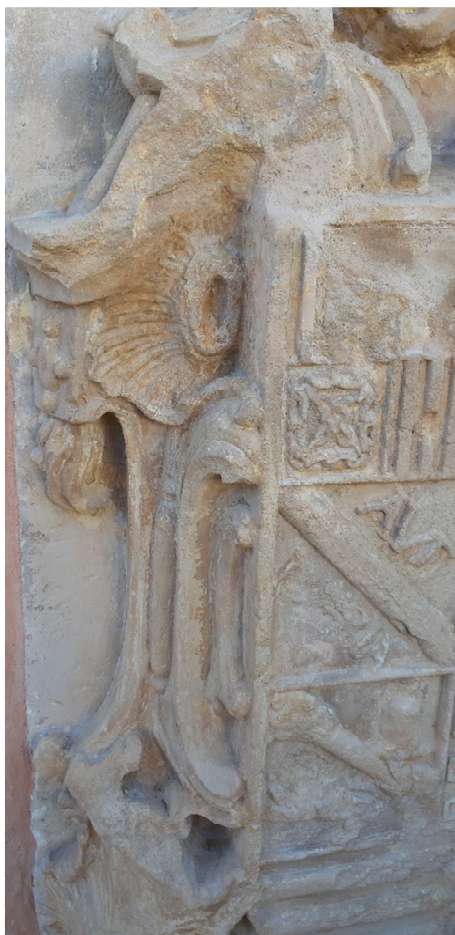
Fig. 14 y 15. Aplicación de una pátina de agua de cal y pigmentos tierra y conservación de restos pictóricos originales.
