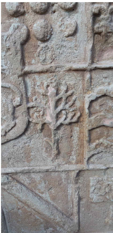
Fig.12. pequeñas reconstrucciones y sellado de fisuras
