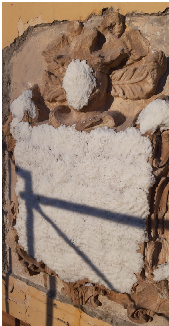
Fig.6. Proceso de eliminación de sales del interior del escudo
