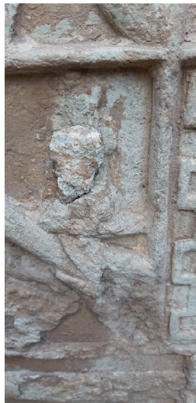
Fig.10 y 11. Pegado de fragmentos con adhesivo epoxídico araldit piedra.
