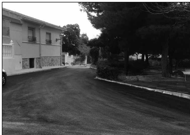
Una de las actuaciones de asfaltado que se ha llevado a cabo en el Chinorlet.
